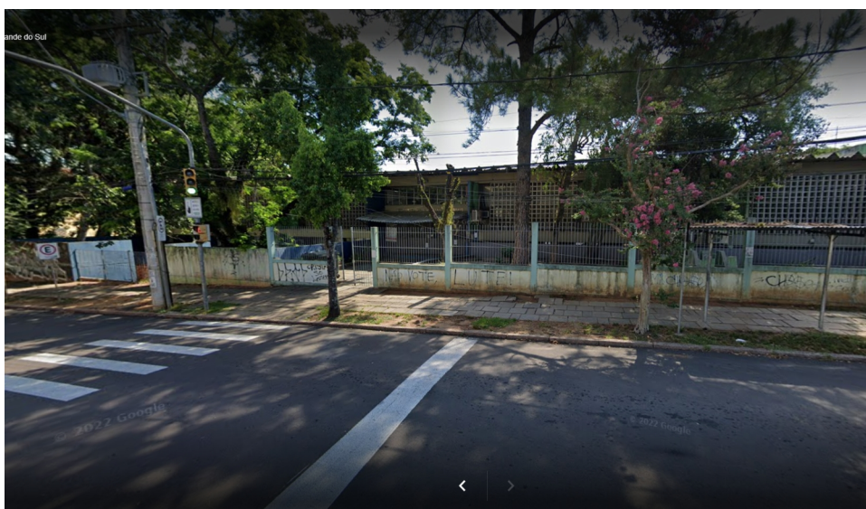
Figura 1: Fachada da escola. Fonte: Google Earth.
