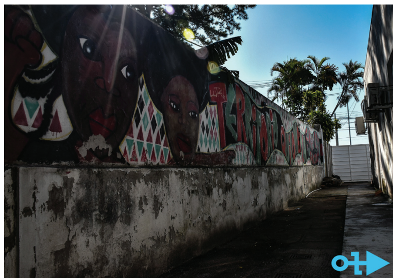
Figura 23 – Muro do corredor de entrada atual do quilombo e, também, limite lateral, que faz divisa com a Fundação.
