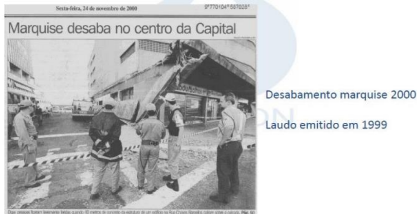
Figura 9 – Registros das consequências da baixa qualidade de Laudos de Inspeção
