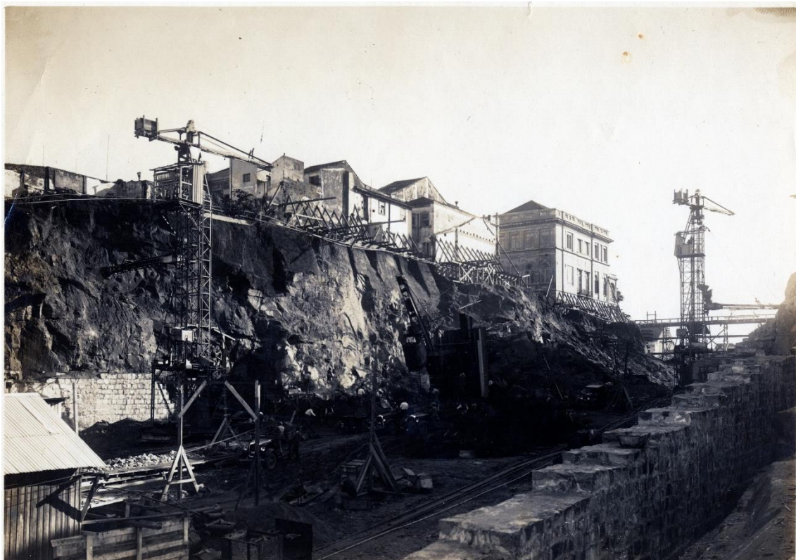
Figura 14 – Obras de abertura da Avenida Borges de Medeiros (década de 1920)
