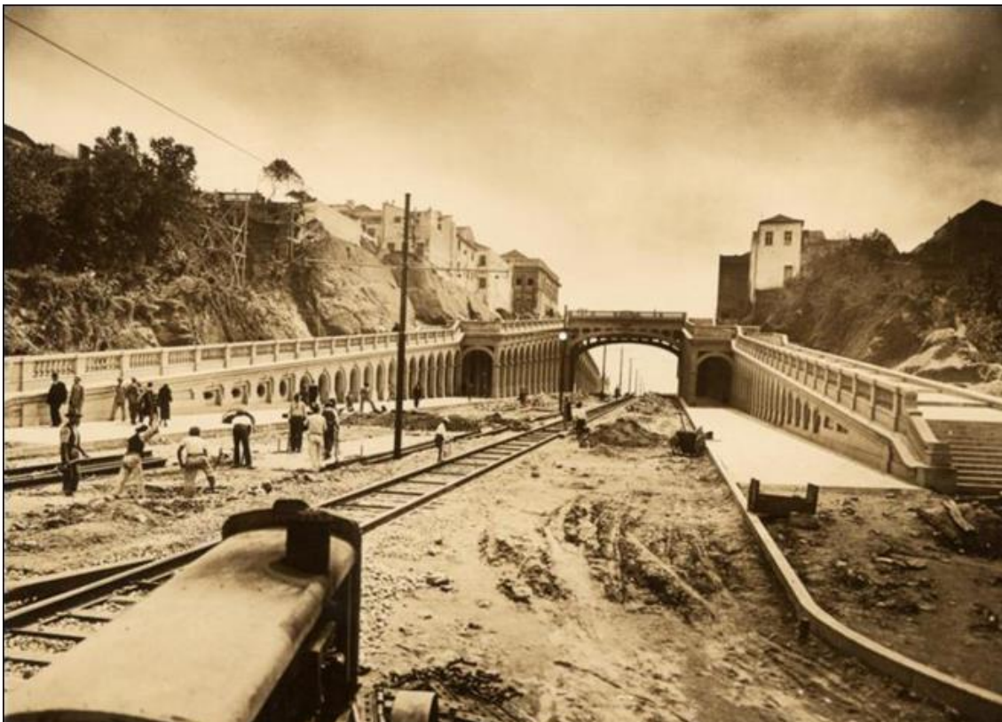
Figura 15 – Obras de abertura da Avenida Borges de Medeiros (década de 1930)
