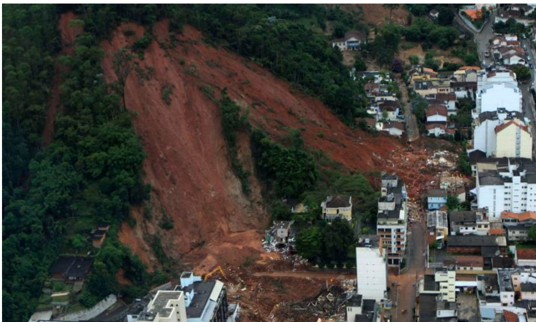
Figura 2 - Escorregamento translacional em Friburgo - RJ.
