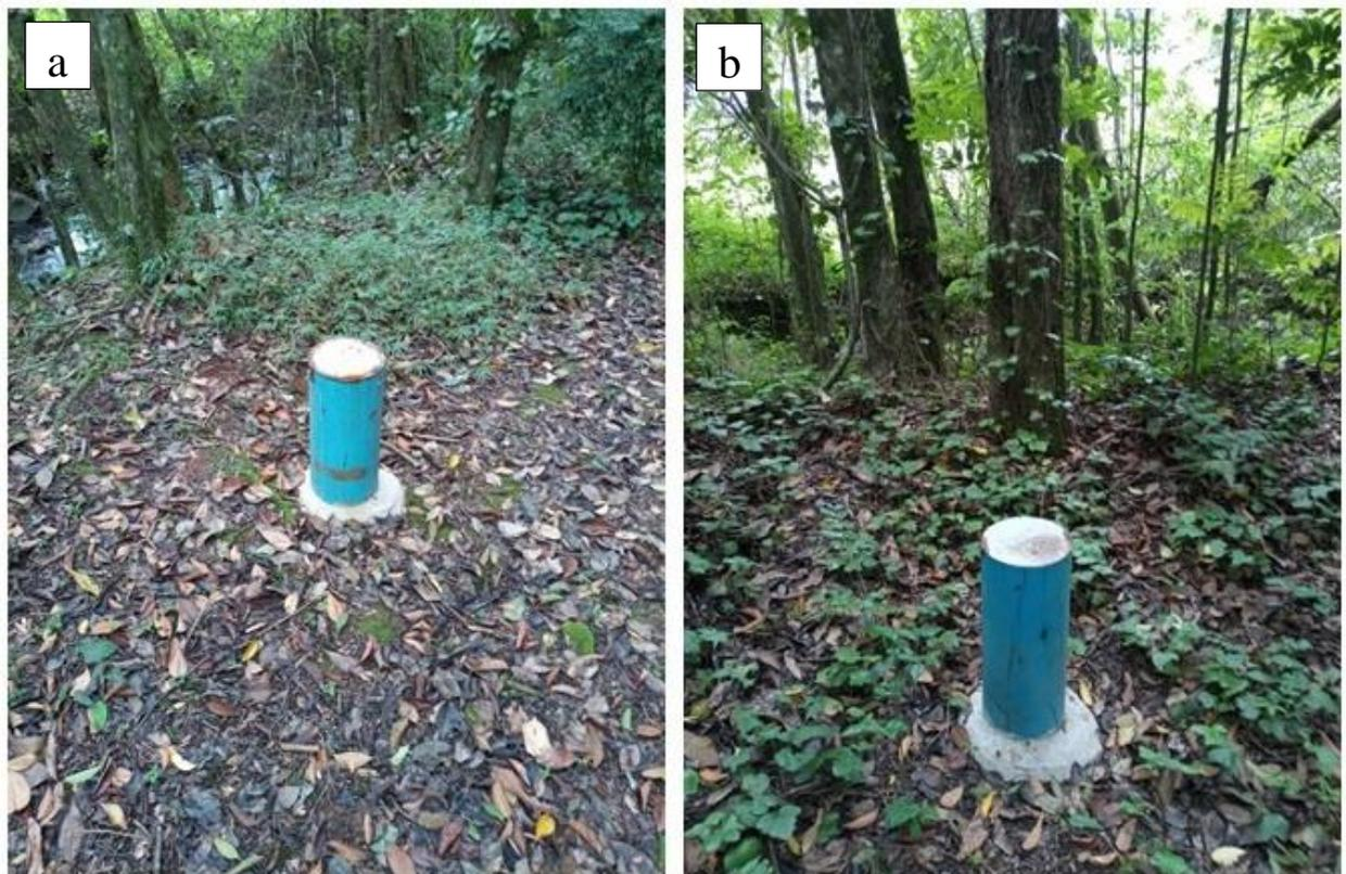
Figura 38 – Piezômetros instalados na bacia: a) PM2; b) PM3
