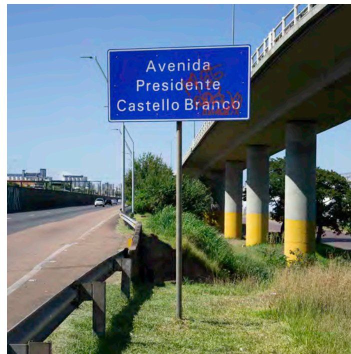
Imagem 2.1.12. Av. Presidente Castello Branco, fotografia do conjunto Inquérito de Testemunhas Concretas . Acervo do autor (2021).
