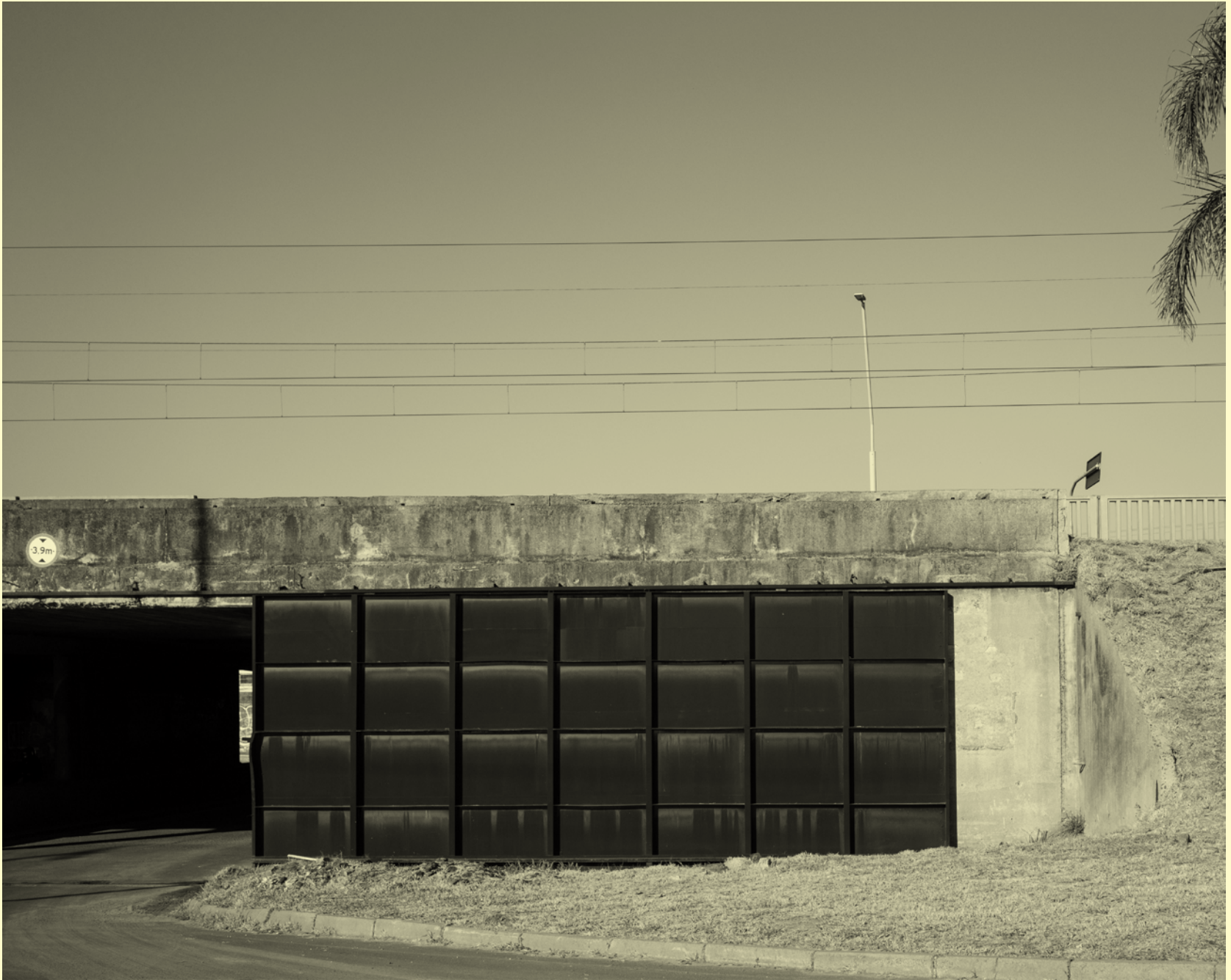
Comporta que protege passagem pelo interior do dique sobre o qual foi construída a Av. Presidente Castello Branco . Porto Alegre, 2022.
