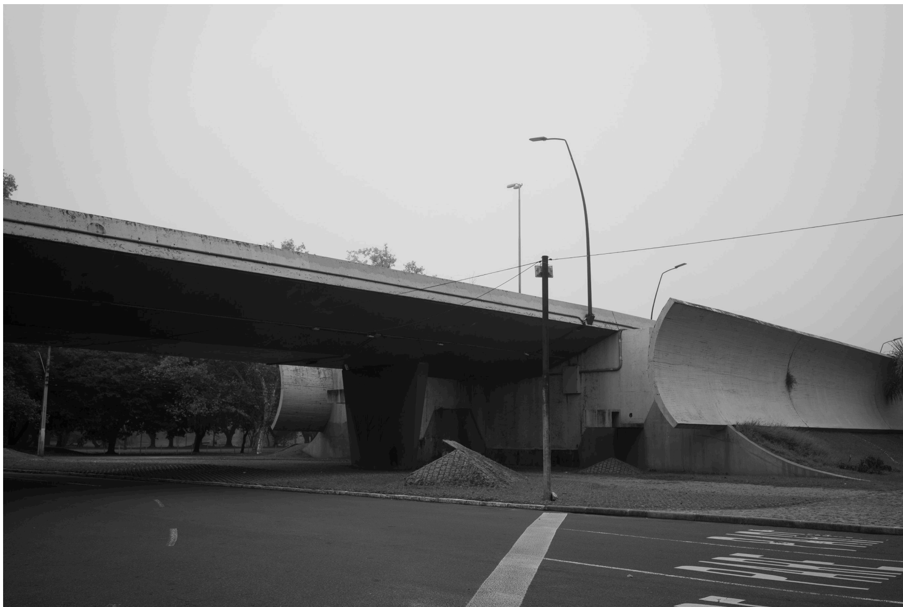
Imagem 2.6. Viaduto Dom Pedro I, fotografia do conjunto Inquérito de Testemunhas Concretas. Acervo do Autor (2021).
