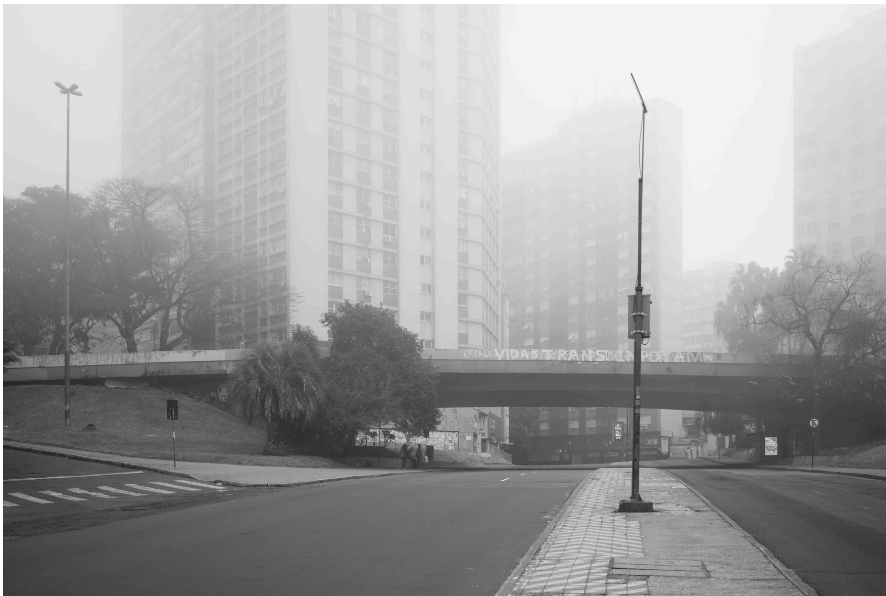
Imagem 2.2. Viaduto Loureiro da Silva, fotografia do conjunto Inquérito de Testemunhas Concretas . Acervo do Autor (2021).
