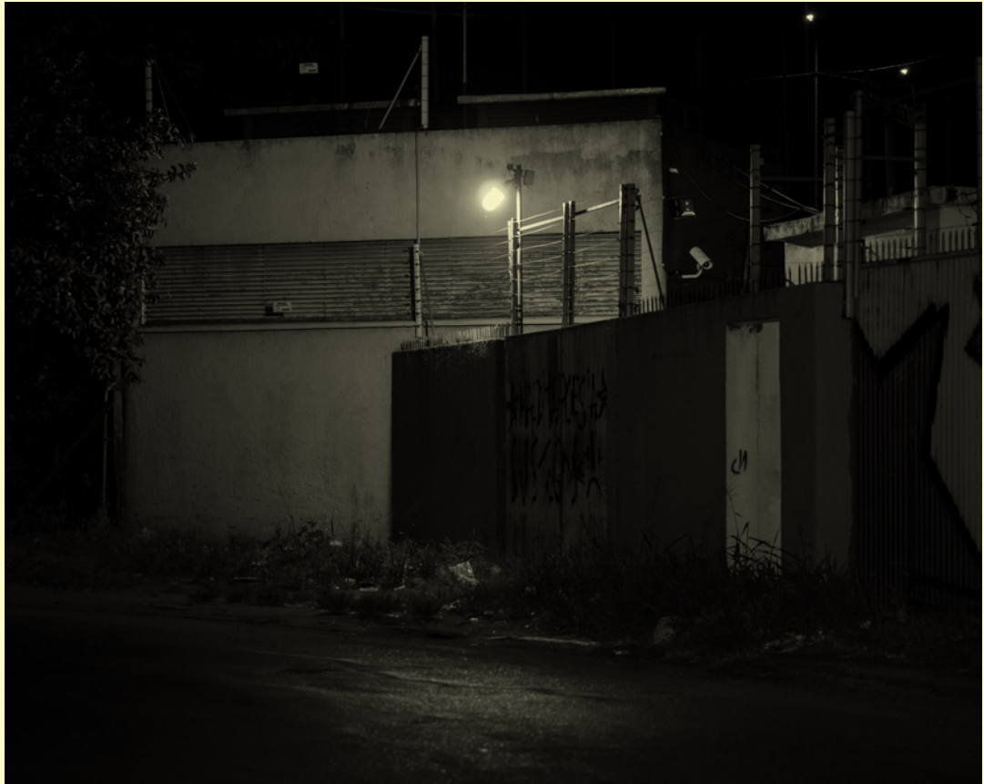
Passagem pelo interior do dique sobre o qual foi construída a Av. Presidente Castello Branco . O ruído do tráfego sobre a passagem é constante. Porto Alegre, 2021.
