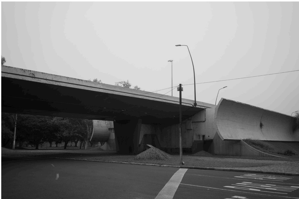
Imagem 3. Viaduto Dom Pedro I, fotografia do conjunto Inquérito de Testemunhas Concretas . Acervo do autor (2021).
