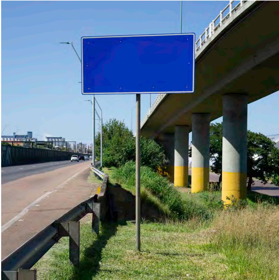
Imagem 2.1.13. Av. Presidente Castello Branco, fotografia do conjunto Inquérito de Testemunhas Concretas. Acervo do autor (2021).
