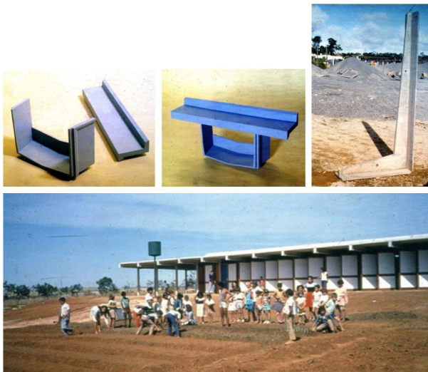
Figura 182: elementos em argamassa armada e escola em Abadiânia, João Filgueiras Lelé
