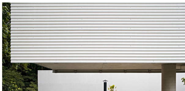
Figura 188: a) casa protótipo Eternit, Carlos Millan; b) e c) casa Carapicuíba - fachada e detalhe - Angelo Bucci
