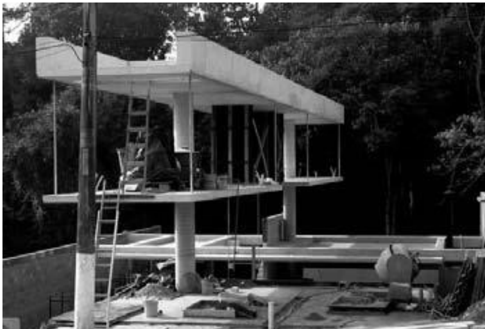
Figura 157: representação de híbridos com a fileira única de apoios - casa Carapicuíba em obras
