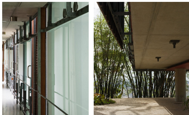
Figura 99: caixilharia da ala longilínea, Santa Teresa
