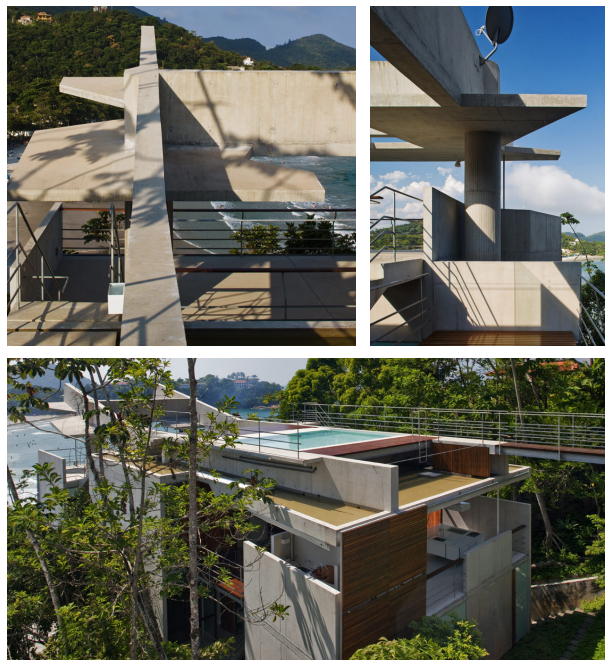
Figura 101: vistas do terraço e detalhes da estrutura, Ubatuba
