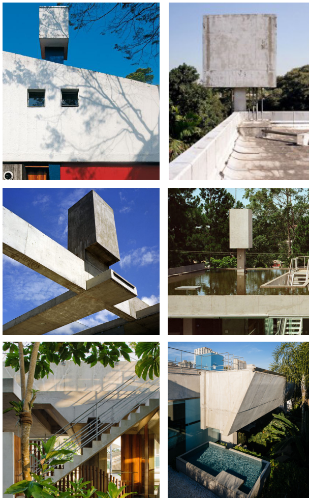
Figura 178: caixas d'água e piscinas – da esquerda para a direita - a) casa Olga Baeta, Vilanova Artigas; b) casa Gerassi, Paulo Mendes da Rocha; c) casa Ribeirão Preto; d) casa Aldeia da Serra; e) casa Ubatuba; f) casa de Fim de Semana - últimas quatro, de Angelo Bucci
