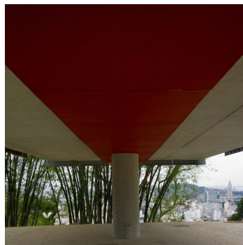
Figura 96: a) fachada sul da ala longilínea; b) painéis suspensos na laje de entropiso da ala longilínea, Santa Teresa
