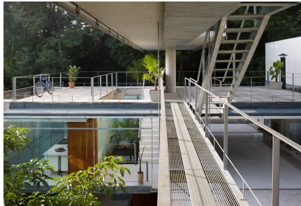
Figura 91: vista da passarela de acesso para o terraço, Carapicuíba Fonte: Nelson Kon
