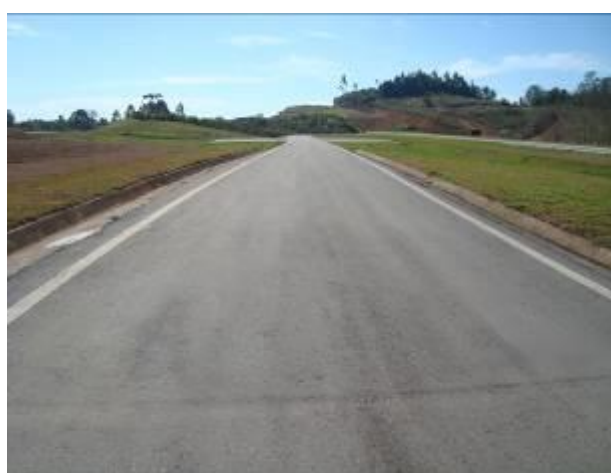
Figura 33 – Pista de alta asfalto (fonte: autor)
