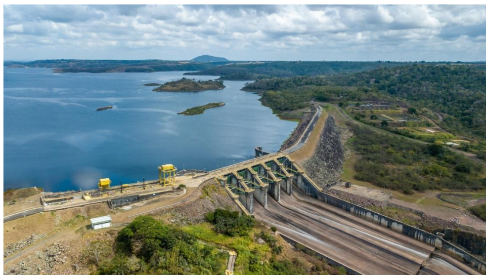
Figura 4-1 – Visão parcial da UHE Pedra do Cavalo
