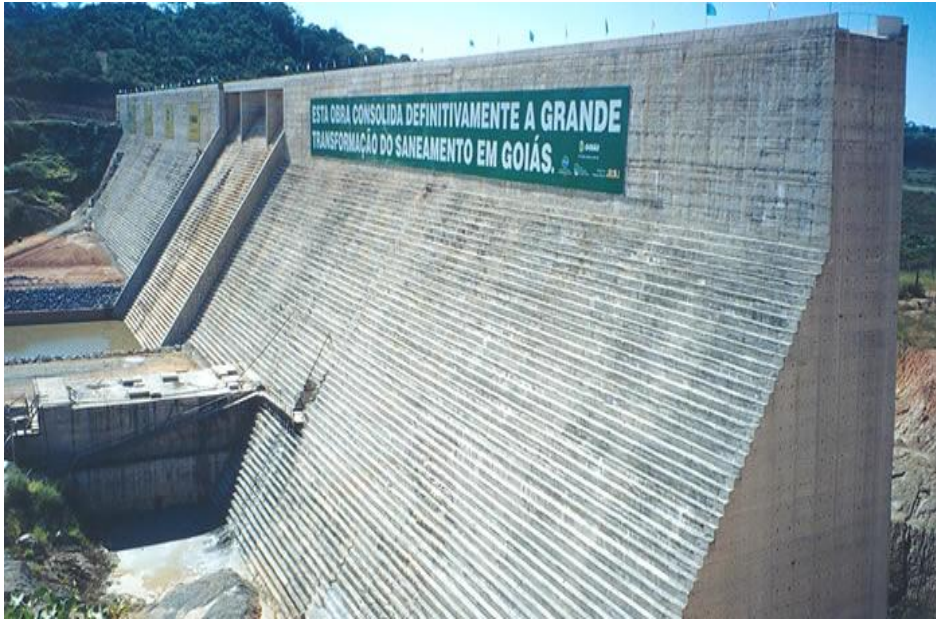
Figura 3-5 – Barragem de concreto tipo gravidade
