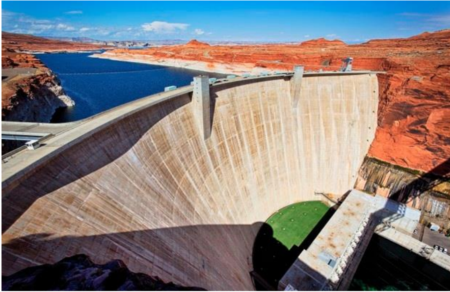
Figura 3-7 – Barragem de concreto tipo arco
