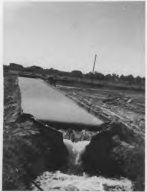
FOTO 2 - RESERVATÓRIO DE 60.000 LITROS.
