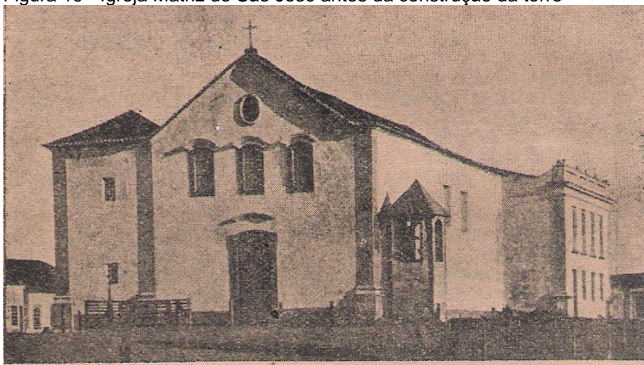
Figura 19 - Igreja Matriz de São José antes da construção da torre
