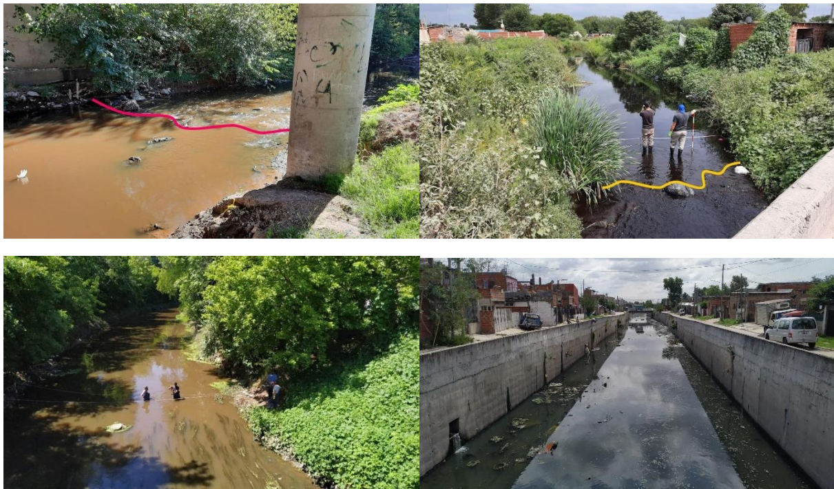
Figura 2.- Secciones de control por macrorugosidades en el fondo (a y b) marcadas con líneas de colores, terrazas en margen izquierda (c) y sección rectangular sin controles hasta el desborde (d).
