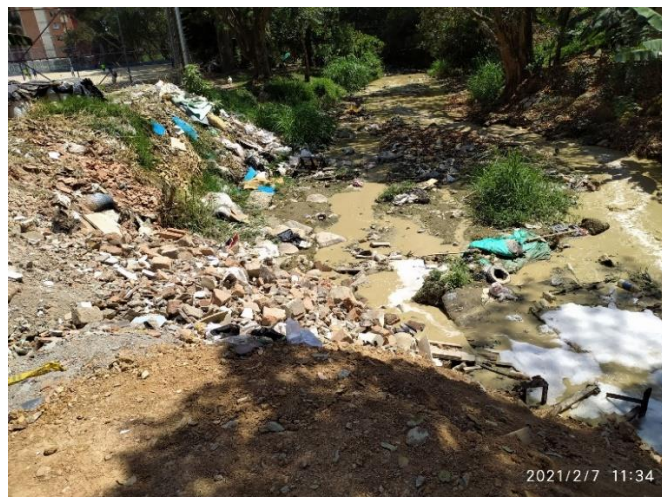
Figura 8. Erosión de las bancas en puntos críticos 11, 12 y 13
