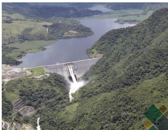
Figura 1.- Panorámica sitio de presa proyecto hidroeléctrico Porce II. Fuente: Integral S.A.
