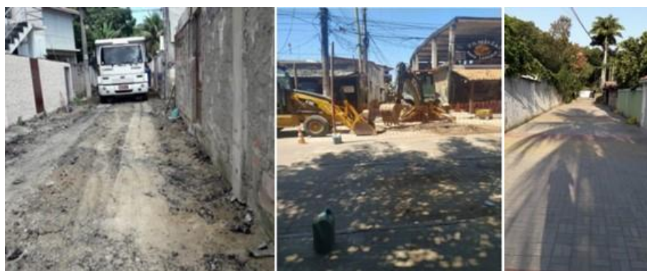
Figura 4. -Fotos das obras da comunidade da Saibreira mostrando o antes, durante as obras de drenagem e o depois com a drenagem e pavimentação concluídas.
