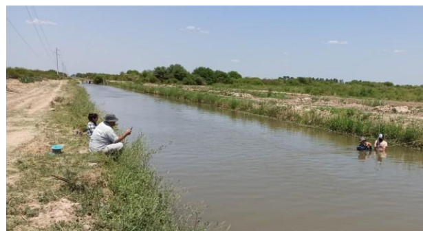
Figura 2.- Apariencia típica de un canal estable en el Área del PRD
