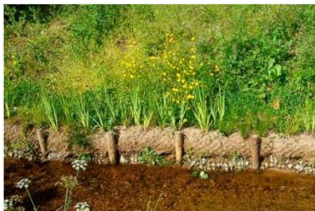
Figura 10.- imagem ilustrativa de solução proposta para estabilização do talude - Implantação de biorrolos.
