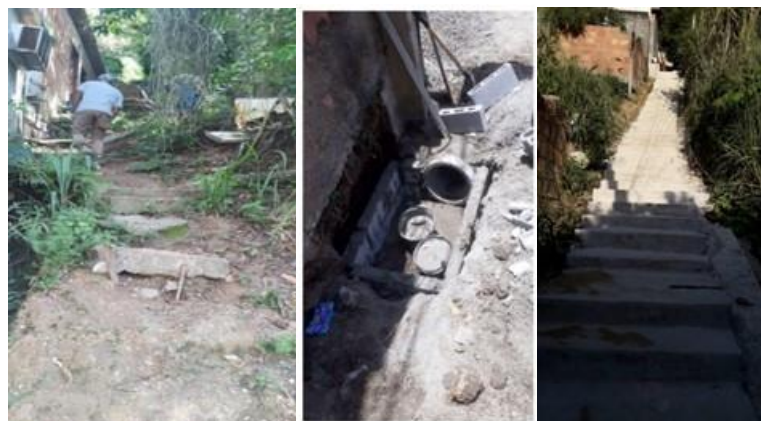
Figura 5. - Fotos das obras da comunidade do Cabrito mostrando o antes, durante a implantação da rede de drenagem em beco da comunidade e o depois com a drenagem e a pavimentação concluídas.
