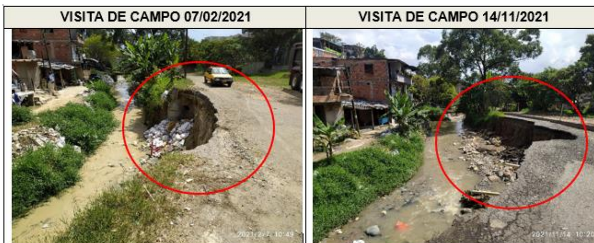
Figura 3. Erosión de talud en la quebrada Altavista (Punto crítico 4)
