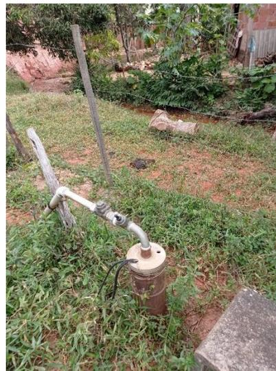
**Figura 4:** Tubulação de um poço profundo utilizado para abastecimento público, em maio de 2022. Fonte: Autoria Própria.
