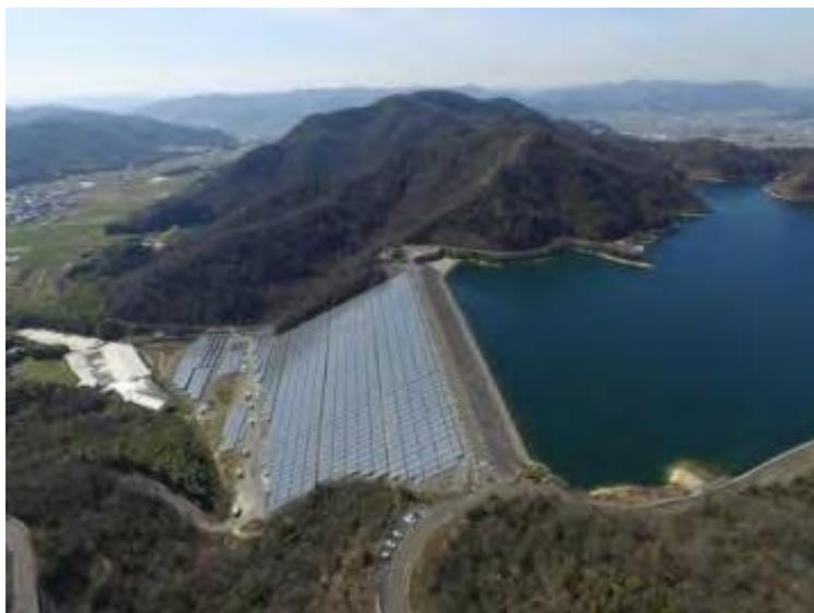
**Figura 5.-** Presa Kotani, Gongen y Heiso con sistemas fotovoltaicos en cortinas
