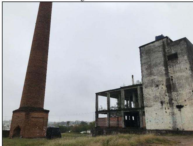
Figura 20 - Remanescentes do Frigorífico Swift Armour em Rosário do Sul/RS
