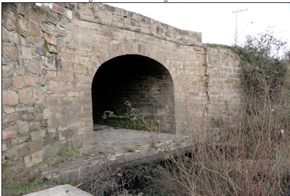
Figura 28 - Ponte da Sanga da Saboeira
