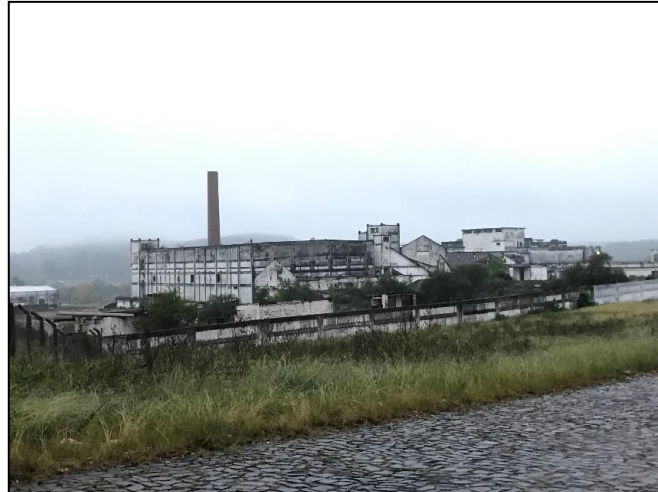
Figura 19 – Remanescentes do Frigorífico Swift Armour em Santana do Livramento/RS
