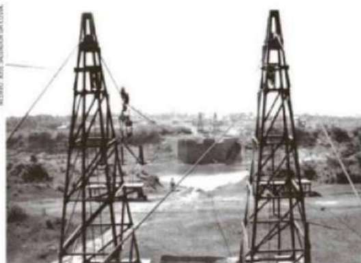
A produção de charque era transportada para Artigas, no Uruguai, por meio de um sistema de cabos aéreos instalado sobre o Rio Quaraí, o Aerocarril
