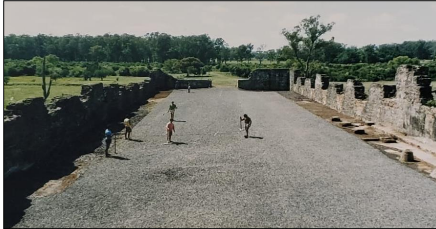
Figura 25 - Obra de revitalização do saladeiro São Carlos de Quaraí em 1991
