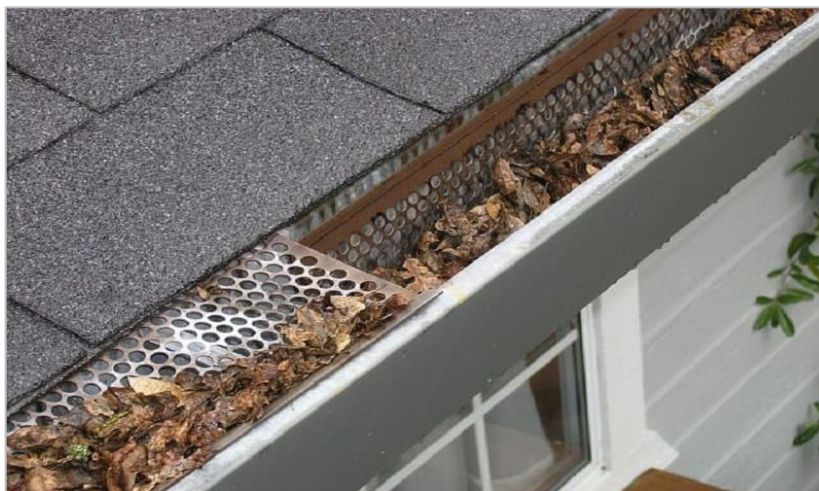
Figura 12. Calhas e lajes
