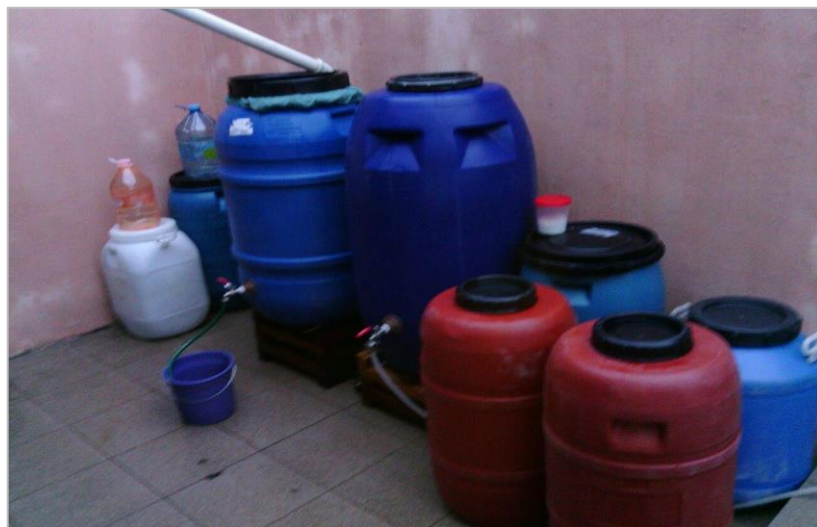
Figura 10. Tonéis e depósitos de água
