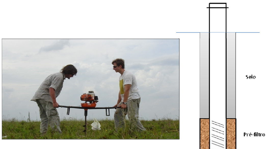
Figura 8. Perfuração de poço com trado mecânico e perfil esquemático do poço executado.
