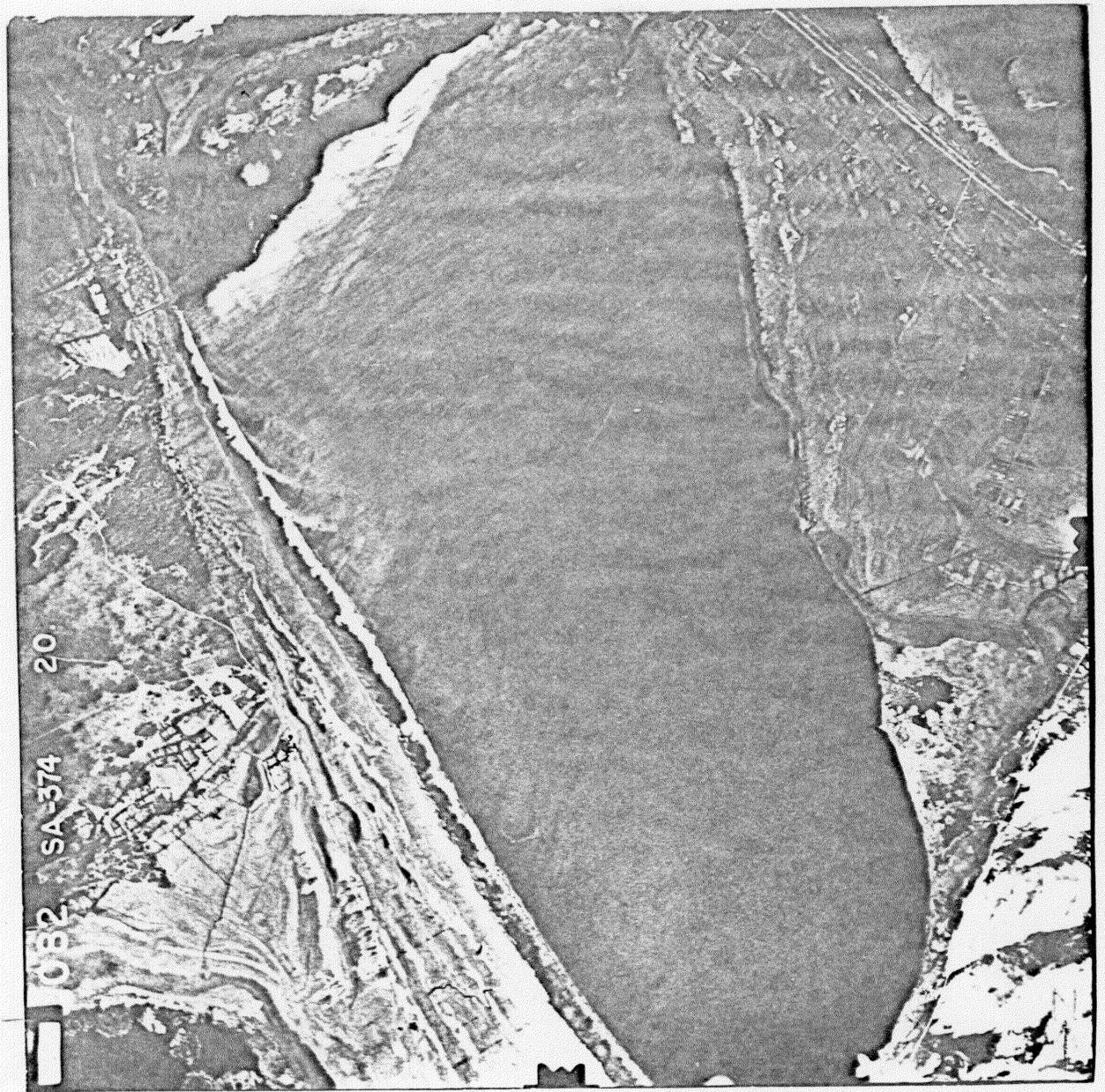
Fig. 18 - Vista aérea da Lagoa das Custódias
