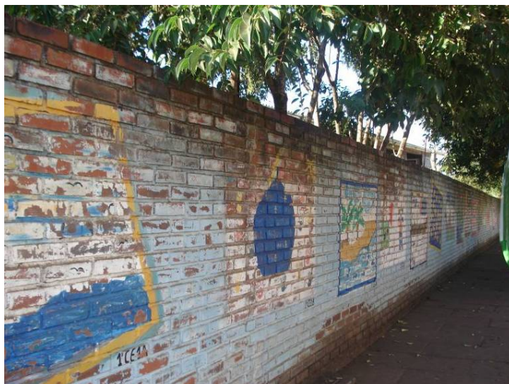
Figura 6 – Vista parcial do muro da escola
