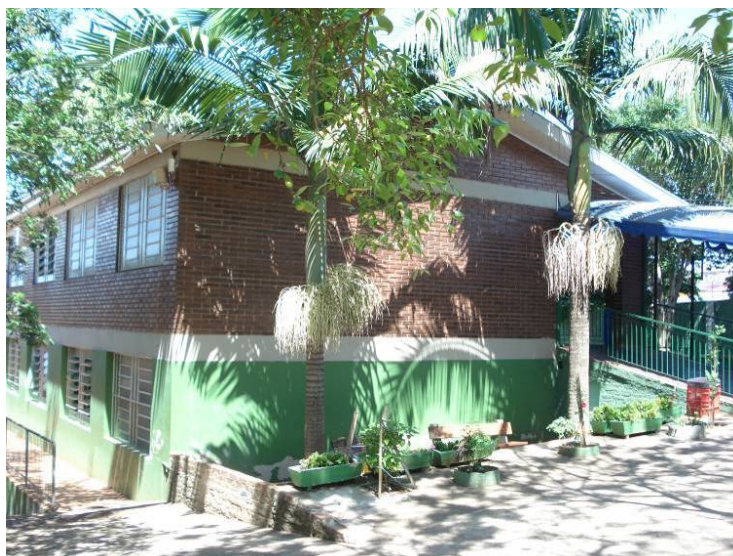
Figura 8 – Bloco 1: com vista parcial da rampa de acesso
