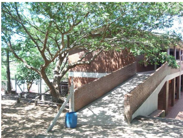
Figura 9 – Bloco 2 da escola
