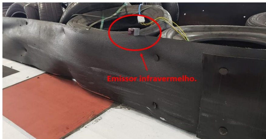
Figura 20 - Emissor infravermelho instalado na pista.
