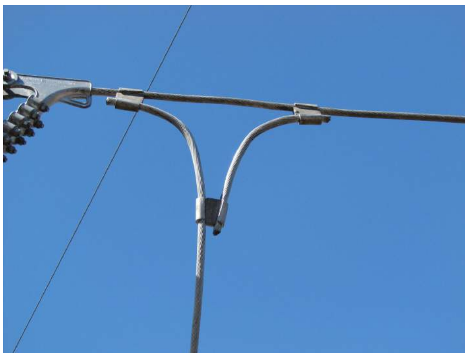
Figura 16 - O “pé-de-galinha” formado por três conectores cunha
