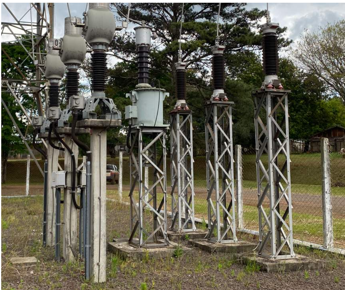
Figura 19 - Estruturas de diferentes materiais em SE Cruz Alta 1
