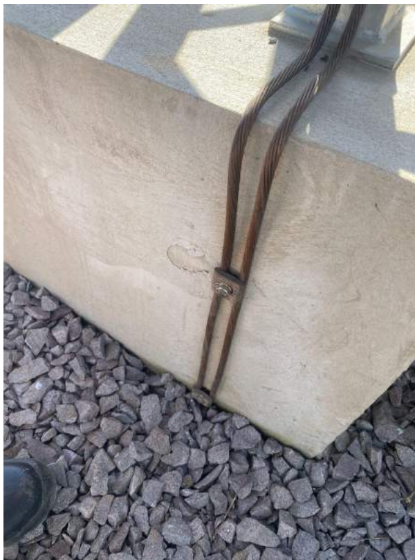
Figura 14 - Descida de aterramento
