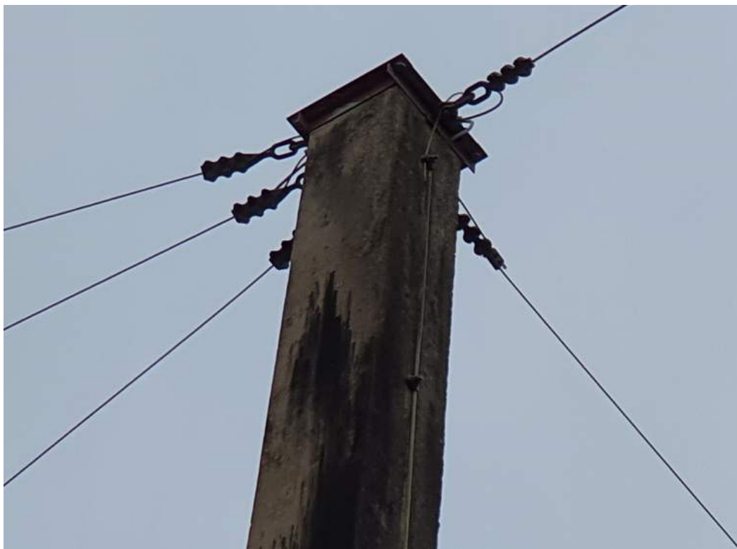
Figura 15 - Conjunto de fixação do cabo de cobertura
