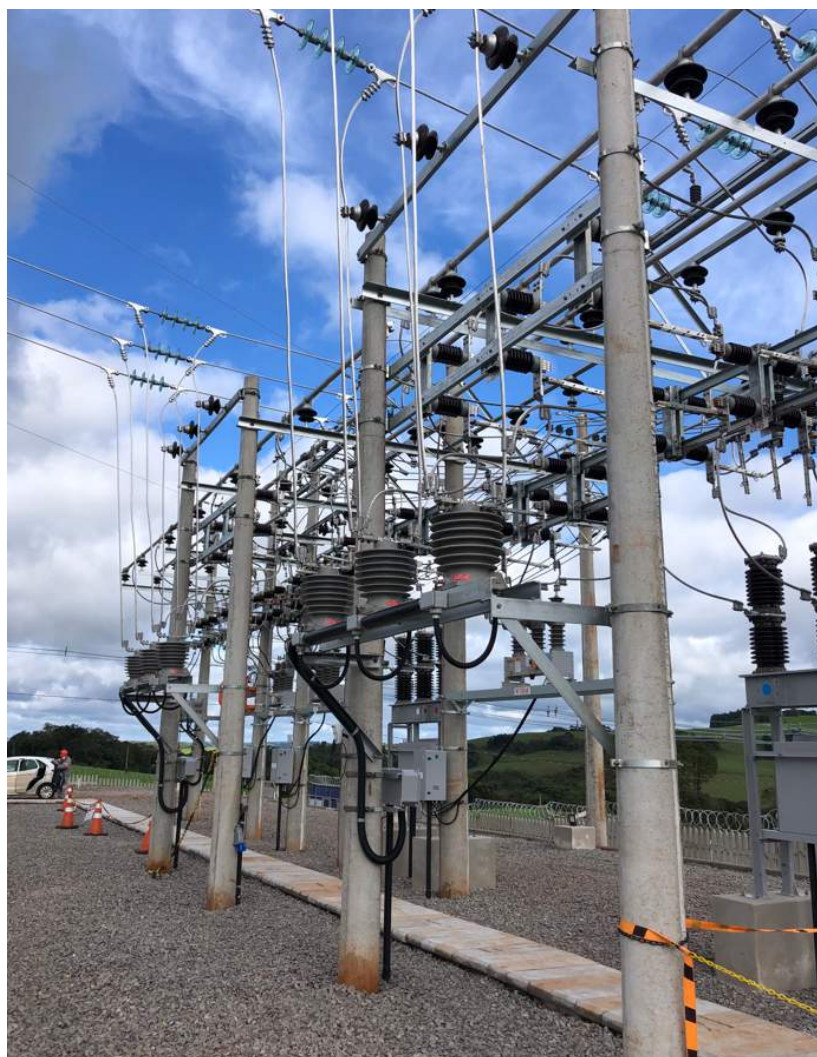
Figura 20 - SE Marau 2, módulos com postes de seção circular
