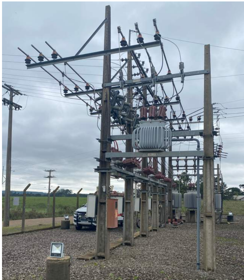
Figura 21 - SE Tainhas, módulos com postes de seção duplo T
