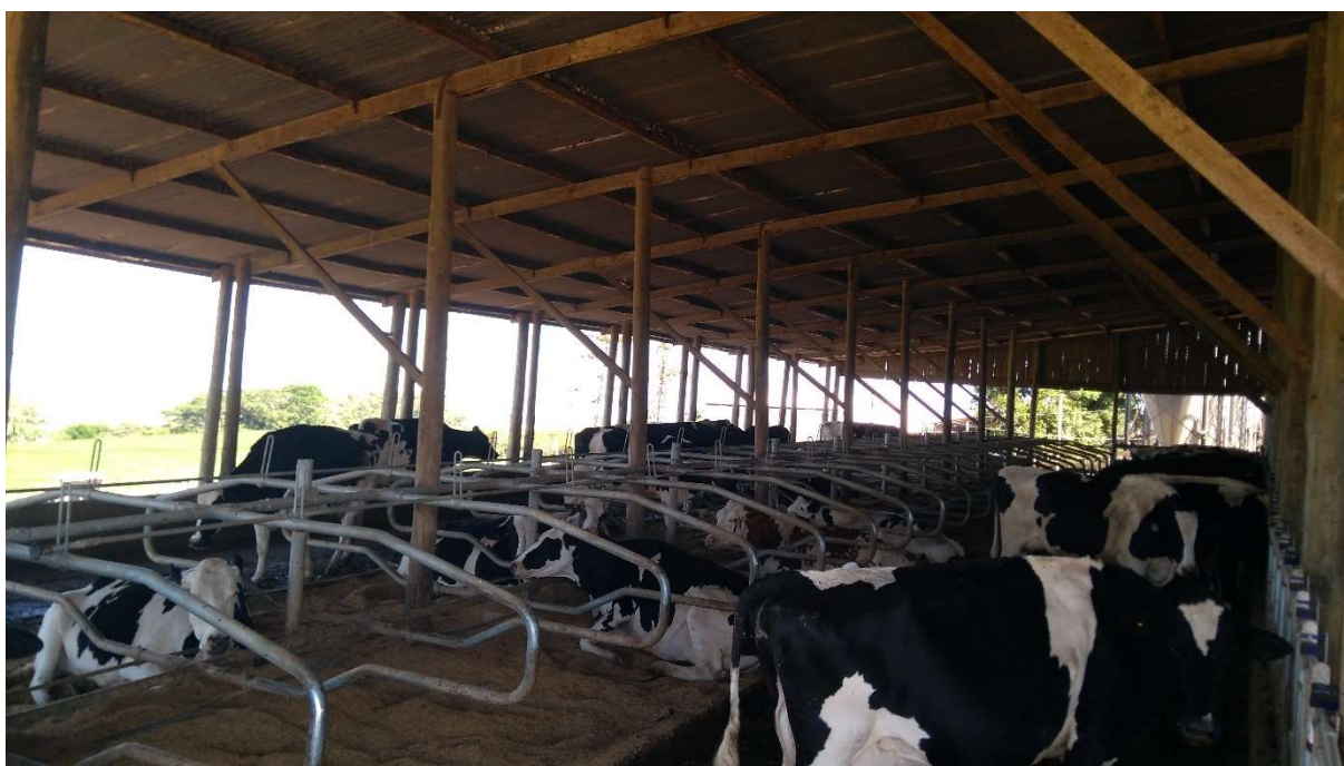
Figura 10: Galpão Free Stall
