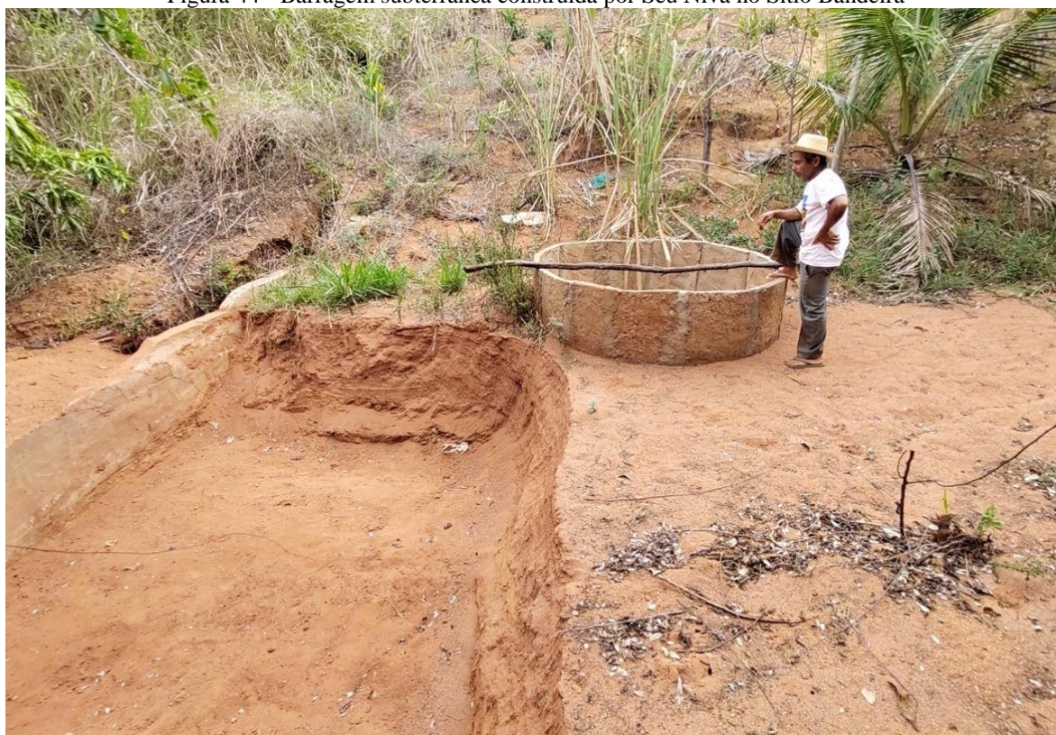
Figura 44 - Barragem subterrânea construída por Seu Nivá no Sítio Bandeira
