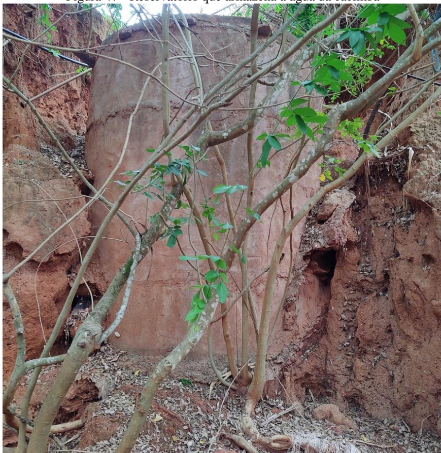
Figura 47 - Reservatório que armazena a água da cacimba
