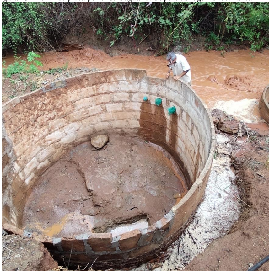
Figura 45 - Túnel de placa por onde a água retida pela barragem subterrânea infiltra
