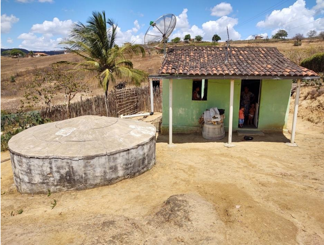
Figura 11 - Uma das primeiras cisternas construídas no município de Cumaru, na casa de Seu Severino
