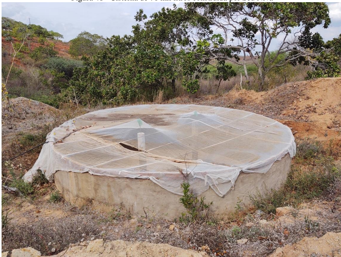
Figura 48 - Cisterna de 70 mil litros construída por Seu Nivá
