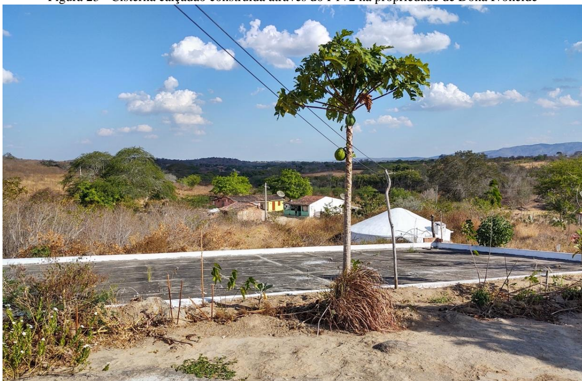
Figura 23 - Cisterna calçadão construída através do P1+2 na propriedade de Dona Ivoneide
