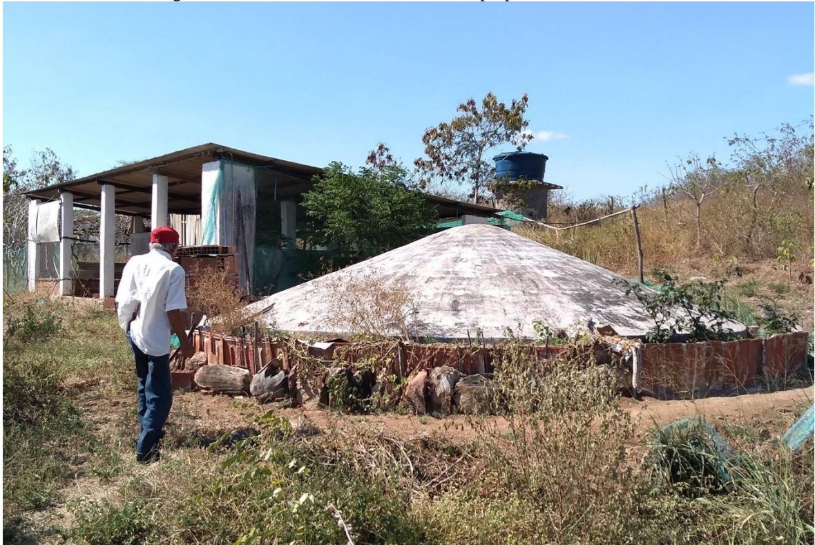
Figura 14 - Cisterna telhadão construída na propriedade de Seu José
