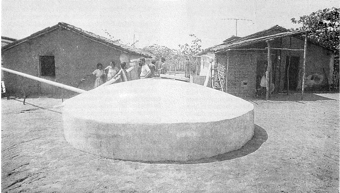
Figura 3 - Cisterna de ferrocimento encontrada por pesquisadores da Rede PTA no estado do Ceará, em 1986
