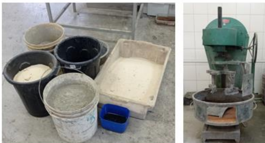
Figura 14 – Materiais e argamassadeira utilizada
