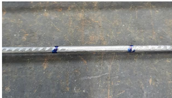
Figura 39 – Lixamento das barras longitudinais (Fonte: Autor)
