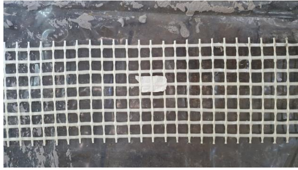
Figura 49 – Proteção do local de instalação do extensômetro (Fonte: Autor)
