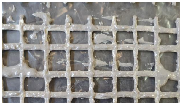
Figura 50 – Execução do revestimento de epóxi (Fonte: Autor)
