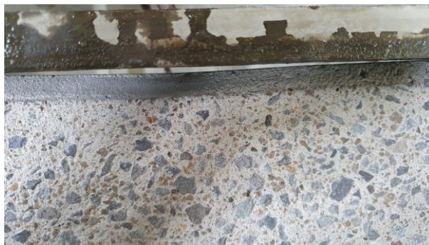
Figura 87 – Imperfeições geométricas das vigas (Fonte: Autor)
