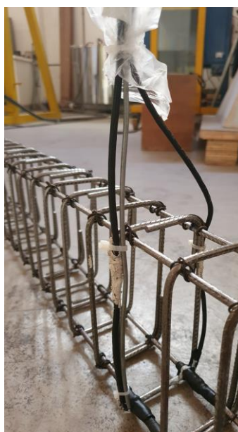
Figura 62 – Fixação da haste metálica (Fonte: Autor)
