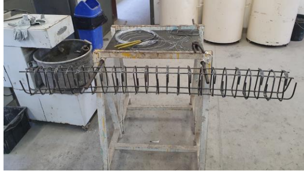
Figura 40 – Montagem das vigas (Fonte: Autor)
