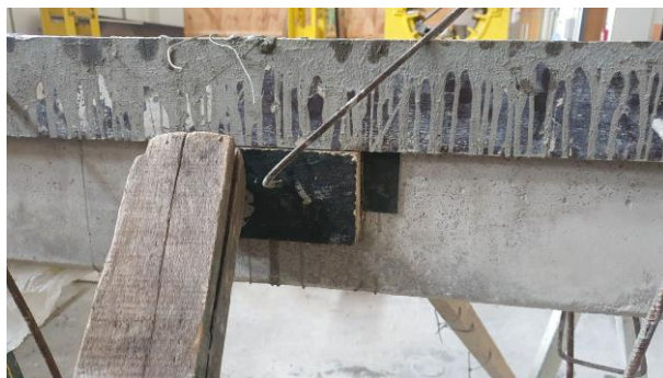
Figura 88 – Elementos do sistema de escoramento externo (Fonte: Autor)
