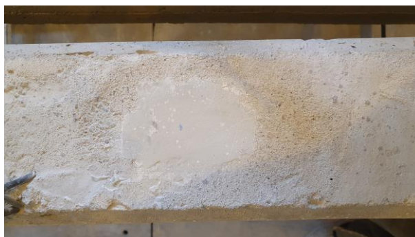
Figura 65 – Uniformização da superfície de concreto (Fonte: Autor)
