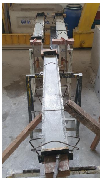
Figura 89 – Escoramento externo (Fonte: Autor)
