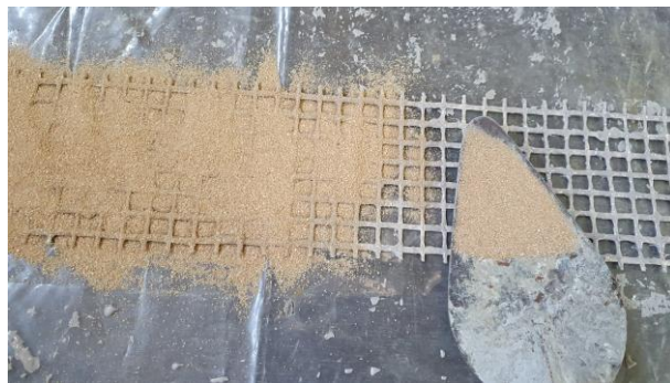
Figura 51 – Execução do revestimento de areia (Fonte: Autor)
