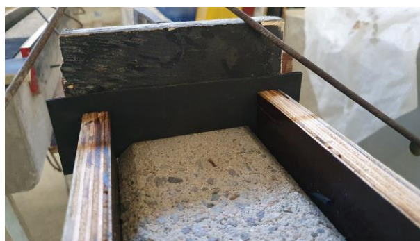
Figura 78 – Contenção lateral da forma (Fonte: Autor)
