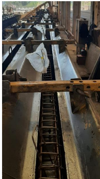
Figura 43 – Preparação para a concretagem (Fonte: Autor)
