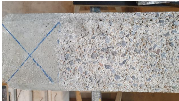
Figura 46 – Superfície jateada das vigas (Fonte: Autor)
