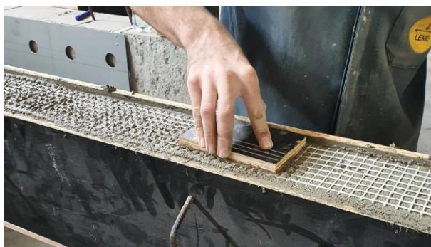
Figura 79 – Posicionamento do têxtil no centro da sua respectiva camada (Fonte: Autor)
