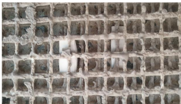
Figura 85 – Posicionamento dos espaçadores (Fonte: Autor)
