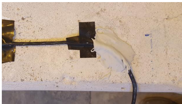
Figura 69 – Proteção do extensômetro com adesivo plástico (Fonte: Autor)
