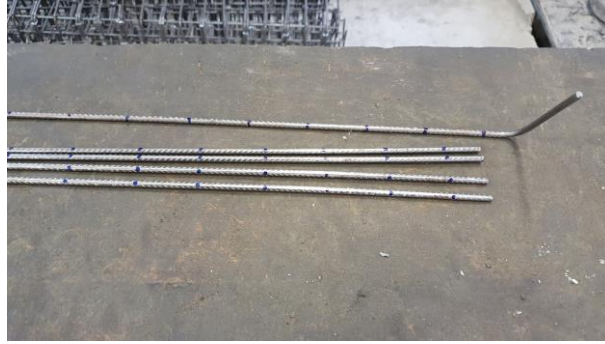
Figura 38 – Marcação das barras longitudinais (Fonte: Autor)
