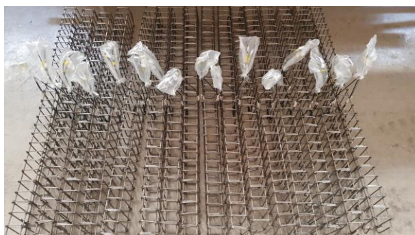
Figura 61 – Proteção dos terminais dos cabos (Fonte: Autor)
