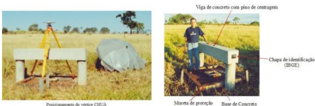
Figura 3.12 – Materialização do Datum horizontal (Vértice Chuá) - Cortesia SOUZA, 2004
