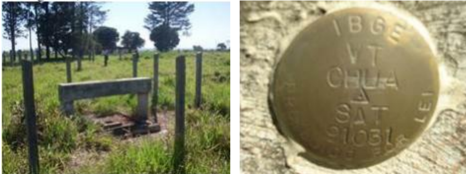
Figura 3.11 – Vértice Chuá e Chapa Indicativa do vértice, na lateral da estrutura de concreto Fonte: SAMPAIO & SAMPAIO, 2013.
