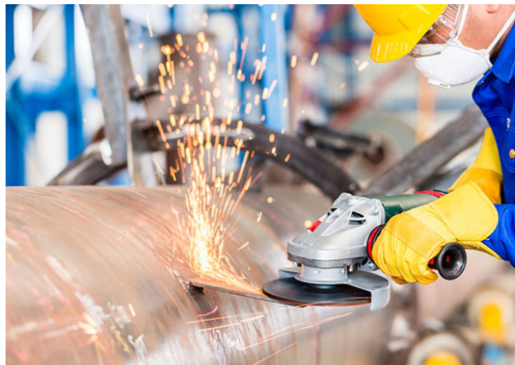
Figura 9 - Método de reparo de lixamento
