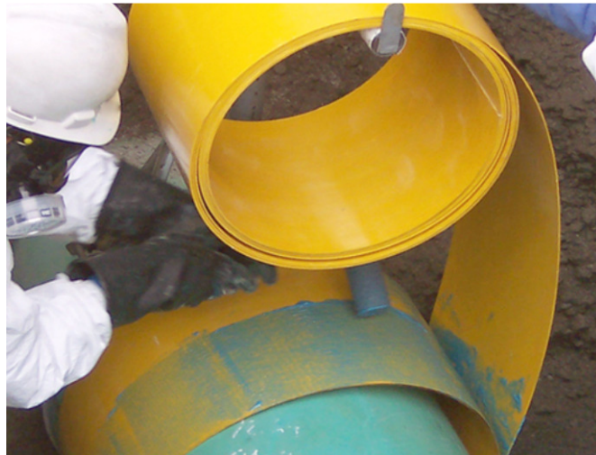
Figura 10 - Método de reparo com mangas de reforço compósitas
