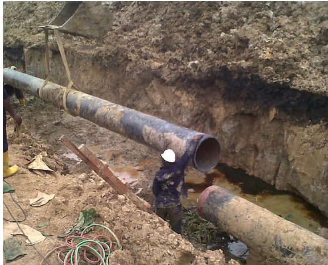
Figura 8 - Método de reparo de remoção e substituição
