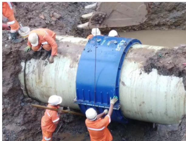
Figura 12 - Método de reparo de aplicação de Abraçadeiras Mecânicas
