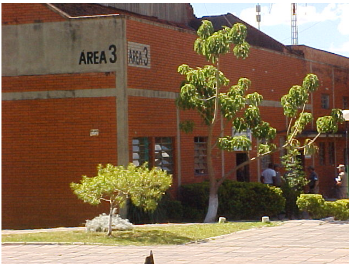
Ilustração 5: prédio da Área 3.
