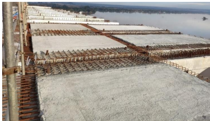
Figura 2.9 – Instalação das lajes pré-moldadas, apoiadas sobre as mãos-francesas
