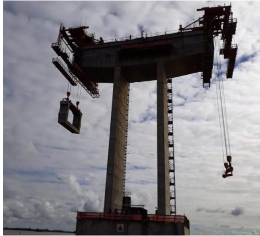
Figura 3.28 – Após a execução da aduela de disparo, iniciou-se a etapa de lançamento das aduelas pré-moldadas
