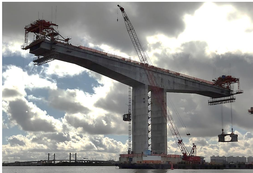
Figura 2.4 – Método dos balanços sucessivos utilizado na construção da Nova Ponte do Guaíba
