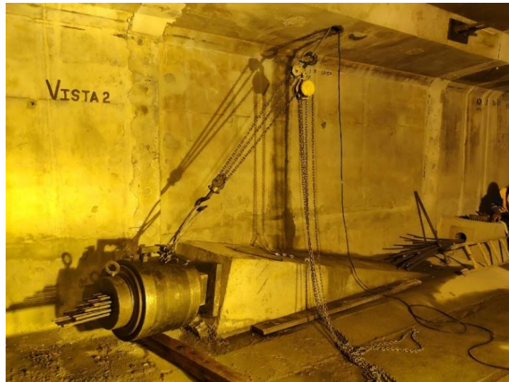
Figura 3.17 – Macaco hidráulico protendendo cabos de protensão no bloco de ancoragem
