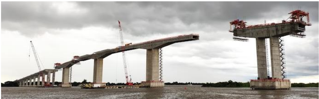
Figura 2.5 – Diversas etapas de construção do tabuleiro ocorrendo simultaneamente
