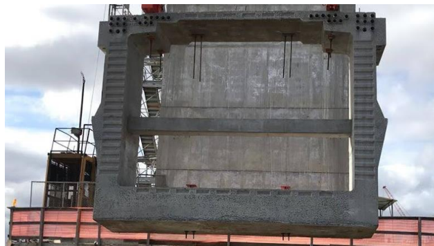
Figura 2.6 – Aduela pré-moldada de concreto em seção caixão
