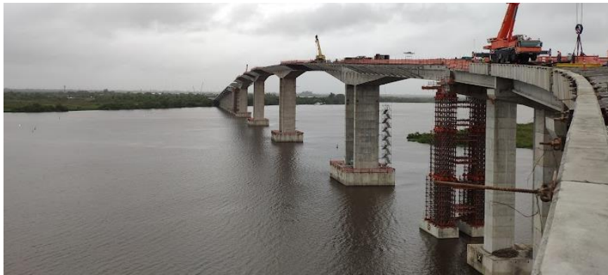
Figura 3.30 – Apoio provisório nos vãos laterais do tabuleiro da ponte
