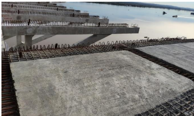
Figura 3.31 – Instalação das lajes pré-moldadas sobre as mãos-francesas
