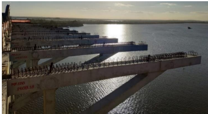
Figura 2.8 – Mãos-francesas pré-moldadas de concreto utilizadas no tabuleiro
