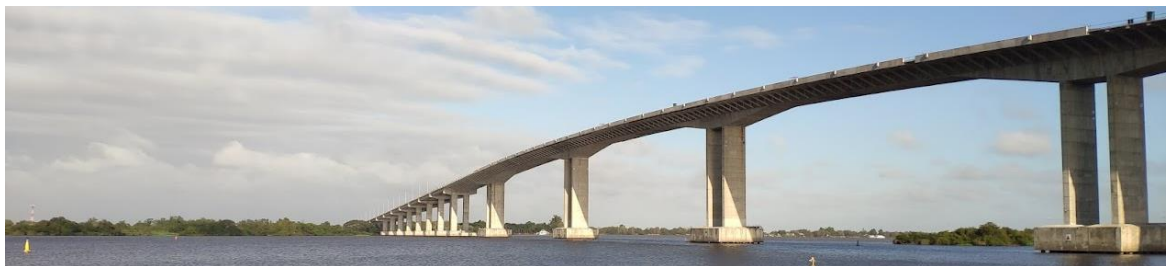
Figura 2.1 – Nova Ponte do Guaíba
