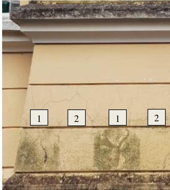
Figura 13 – Autolimpeza da superfície com aspersão de \text{TiO}_2 após 36 meses da aplicação: (1) faixas sem a aplicação de \text{TiO}_2 ; (2) faixas com a aplicação de \text{TiO}_2
