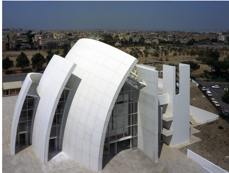
Figura 14 – Igreja Dives in Misericordia, em Roma, com uso de concreto branco com adição de \text{TiO}_2
