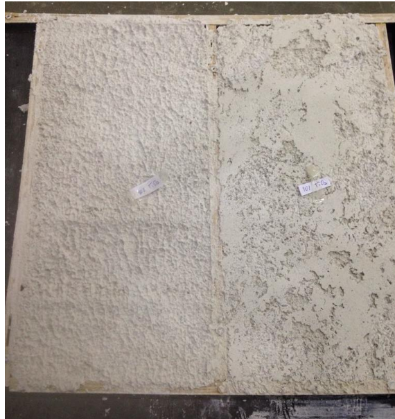
Figura 25 - União de cinco amostras para execução de dois tipos dos acabamentos superficiais: rugoso, à esquerda, e friccionado, à direita
