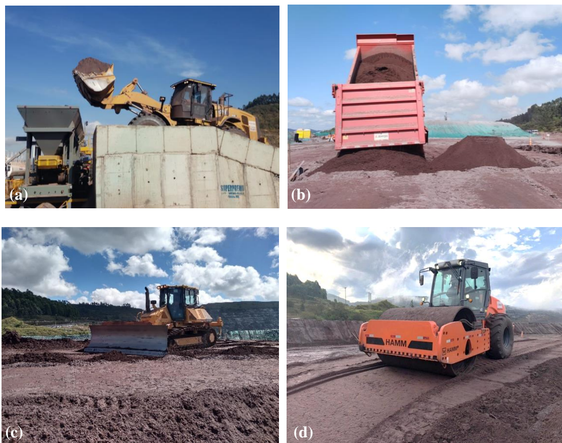
Figura 3.17 – Etapas da execução das pilhas experimentais de misturas de rejeito e cimento Portland CPV – ARI: (a) abastecimento da usina de solos; (b) descarregamento da mistura; (c) espalhamento e nivelamento da camada; (d) compactação da camada
