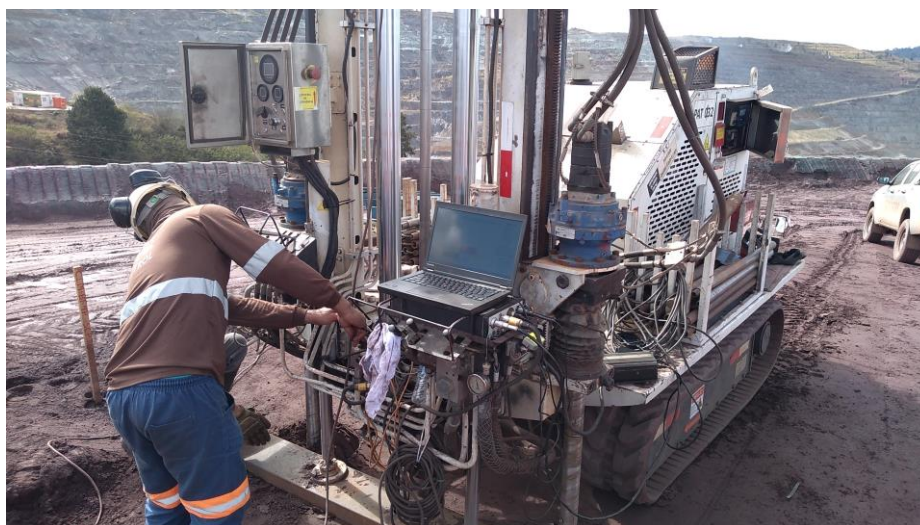
Figura 3.24 – Execução do ensaio CPT
