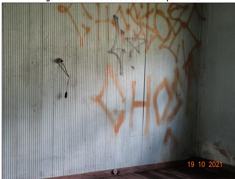
Figura 115 - Detalhe de sala do terceiro pavimento
