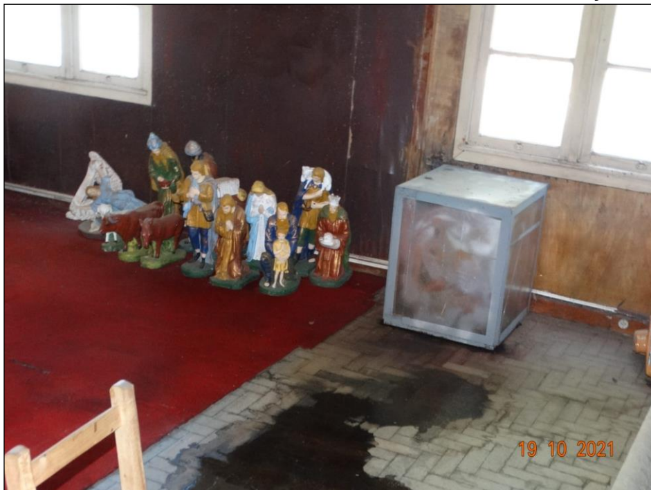
Figura 108 - Detalhe da sala de armazenamento dos artefatos de decoração natalina
