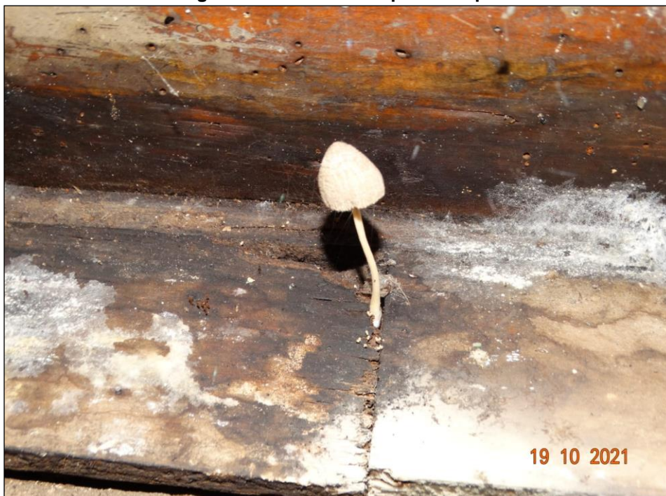
Figura 106 - Detalhe do piso/rodapé
