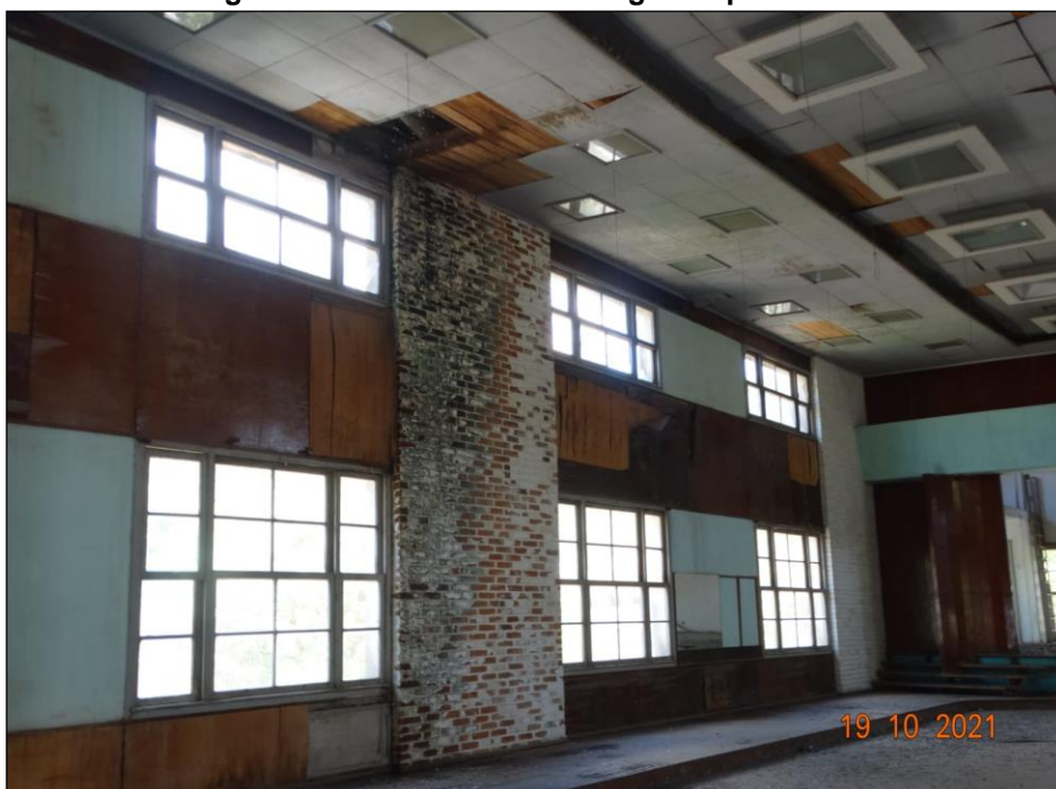
Figura 110 - Salão nobre no segundo pavimento
