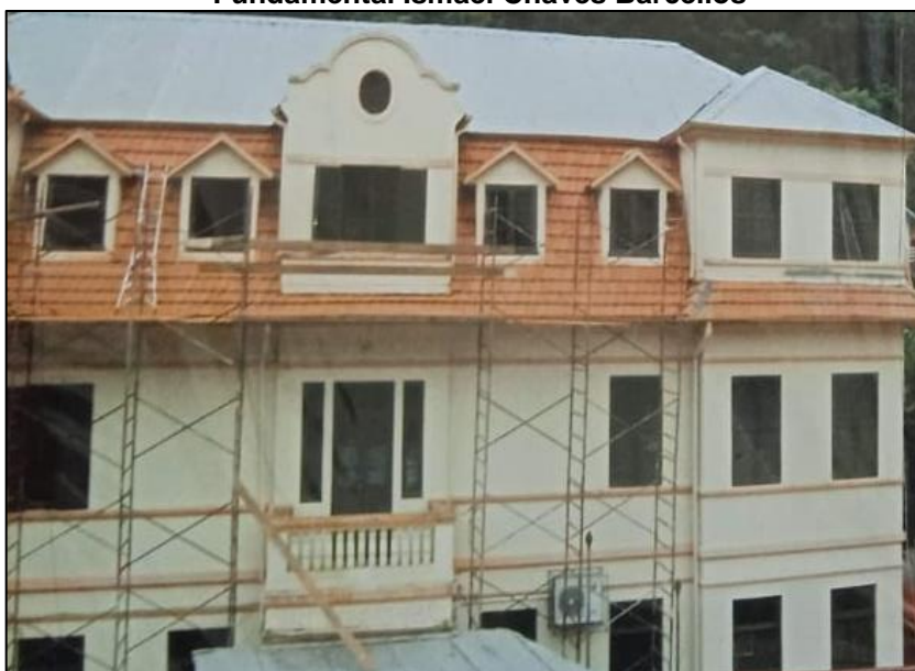
Figura 43 - Processo de restauração do prédio administrativo da Escola Estadual de Ensino Fundamental Ismael Chaves Barcellos
