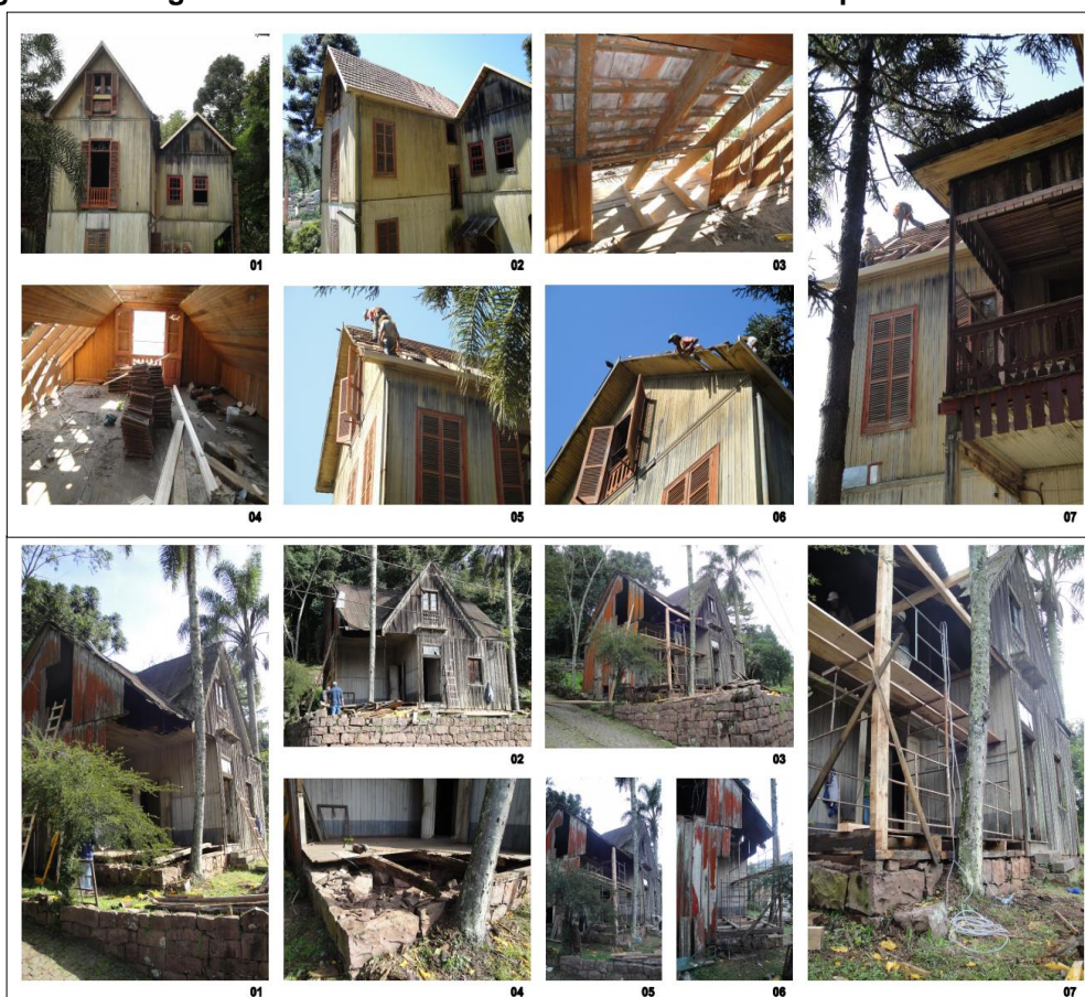
Figura 60 - Fragmentos do memorial de obra sobre o início do processo de restauro
