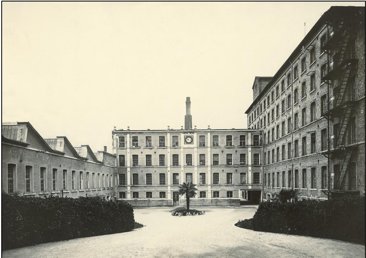
Figura 6 - Fachada da Fábrica Alta do Lanifício Rossi
