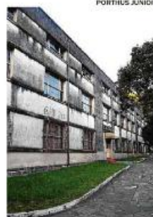
O prédio à época da interdição por risco de incêndio, em 2019
