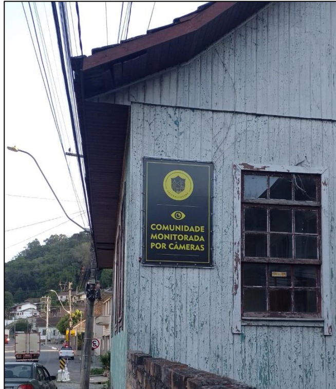
Figura 33 - Placa de monitoramento por câmeras
