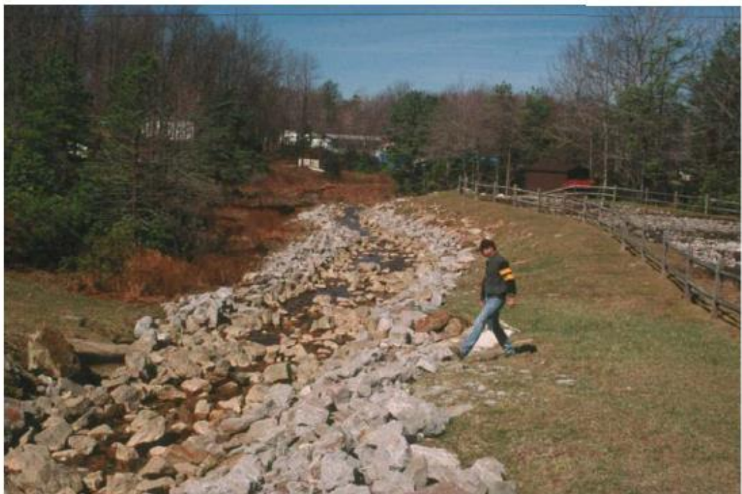
Figura 6 - Exemplo de canal aberto de calcário.
