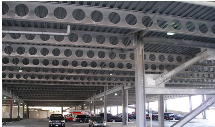
Figura 1.6 – Edifício de estacionamento utilizando vigas celulares (C-BEAMS, 2018)
