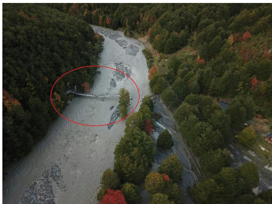
Figura 19. Fotografia da ponte rompida com a inundação. Fonte: AYSÉN, 2018.
