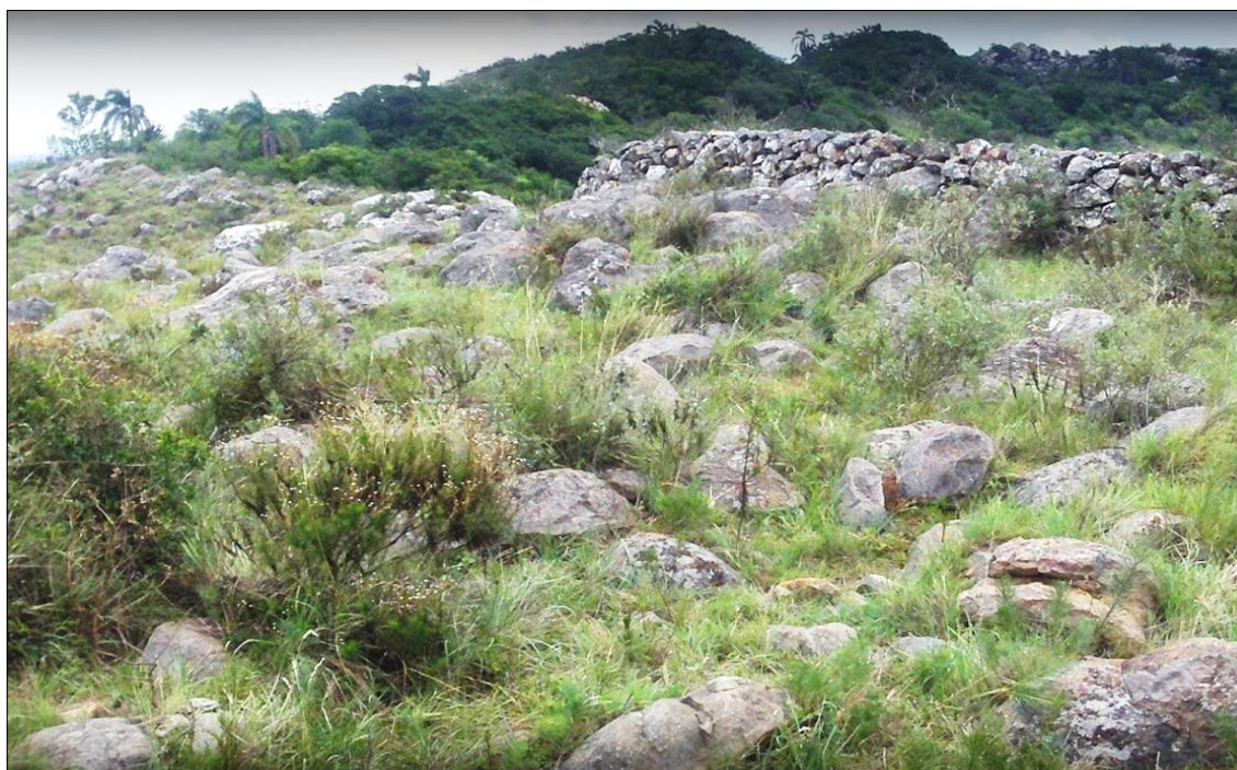
Figura 43 - Muro de Arenito construído pelas tropas no Cerro do Jarau.
