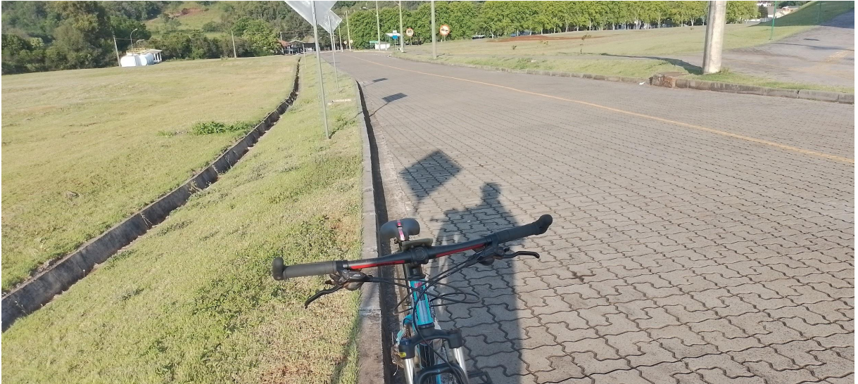
Figura 21 - Via de circulação interna da UFFS, Campus Cerro Largo. Fonte: do Autor, 2022.
