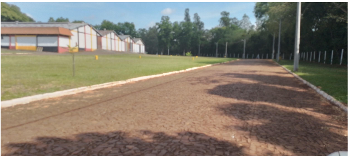
Figura 5 - Via de circulação interna no Parque Municipal Exposições. Fonte: do Autor, 2002.
