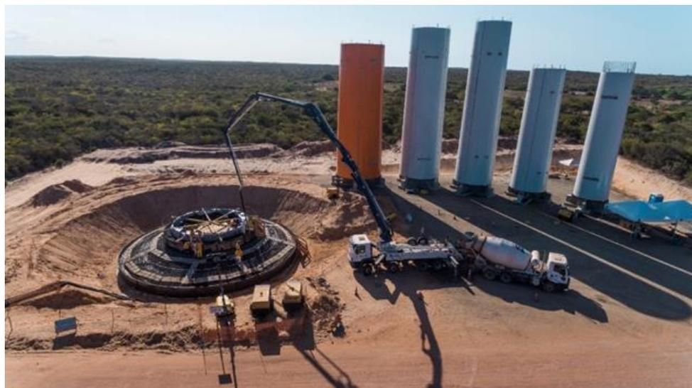
Figura 7 - Estrutura base turbinas eólicas – R2A Engenharia 2020
