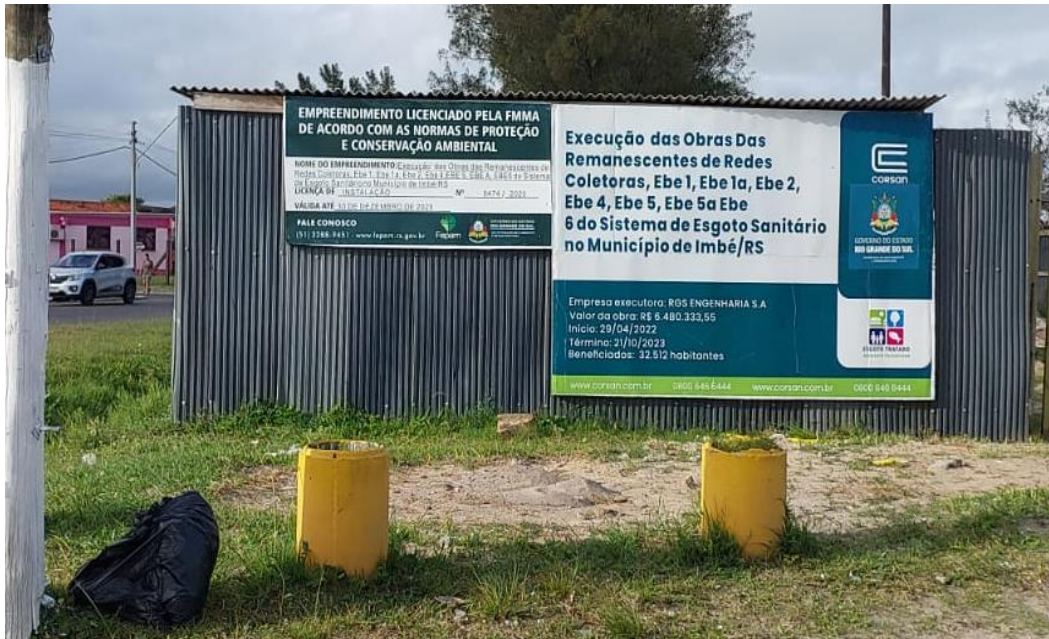
Figura 25 – Placas de obras do Sistema de Esgoto Sanitário, município de Imbé.
