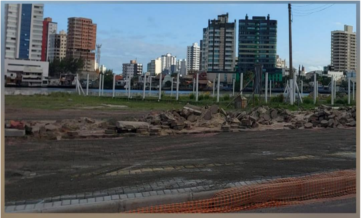
Figura 27 – Obras (calçadão e ciclovia) no entorno da barra em Imbé.
