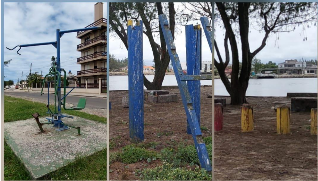
Figura 21 – Estruturas danificadas na “Praça dos Botos”: aparelhos de ginástica (esquerda), escorregador (centro) e bancos (direita).
