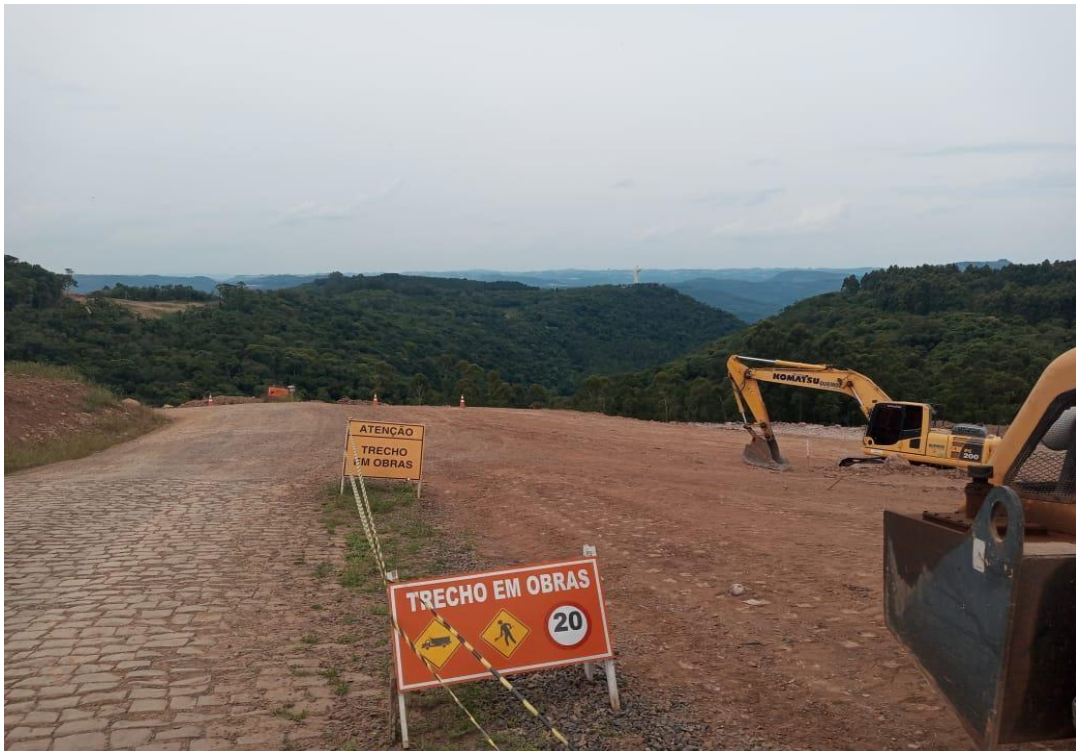
Figura 4 – Obra de Pavimentação do Acesso ao Cristo Protetor.
