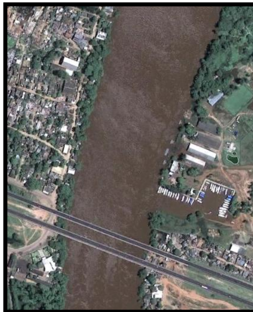
Figura 23: Proximidades do Clube Navegantes São João, na Ilha do Pavão
