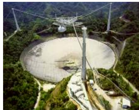
O maior rádio-telescópio do mundo, com 305m de diâmetro, situado em Arecibo, Porto Rico. Contrariamente a antenas menores e a telescópios ópticos, a antena de Arecibo não se move livremente, captando as ondas de rádio emitidas pelas fontes astronômicas quando estas transitam sobre o local onde está montada. Fonte: http://www.naic.edu/
