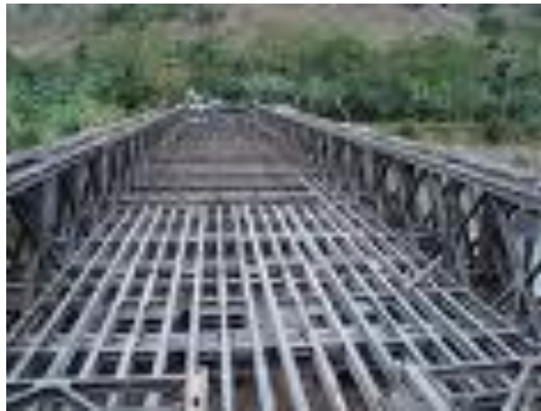
Figura 3.4 – Detalhe elementos de uma ponte Bailey ( www.paolipc.bogspot.com ).
