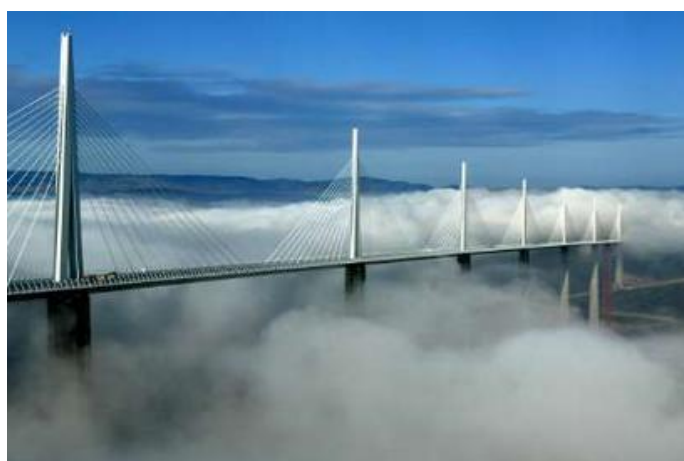
Figura 3.24 – Viaduto de Milau ( http://linhadirecta.blogspot.com ).
