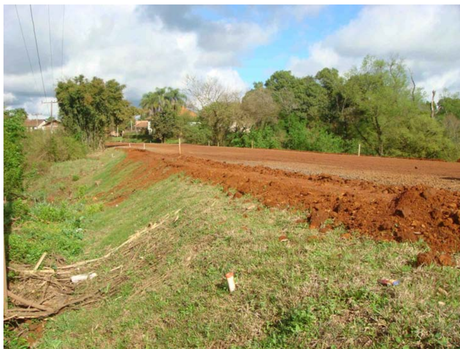
Figura 44 – Elevação da rodovia RS-124, entre Pareci Novo e São Sebastião do Caí.
