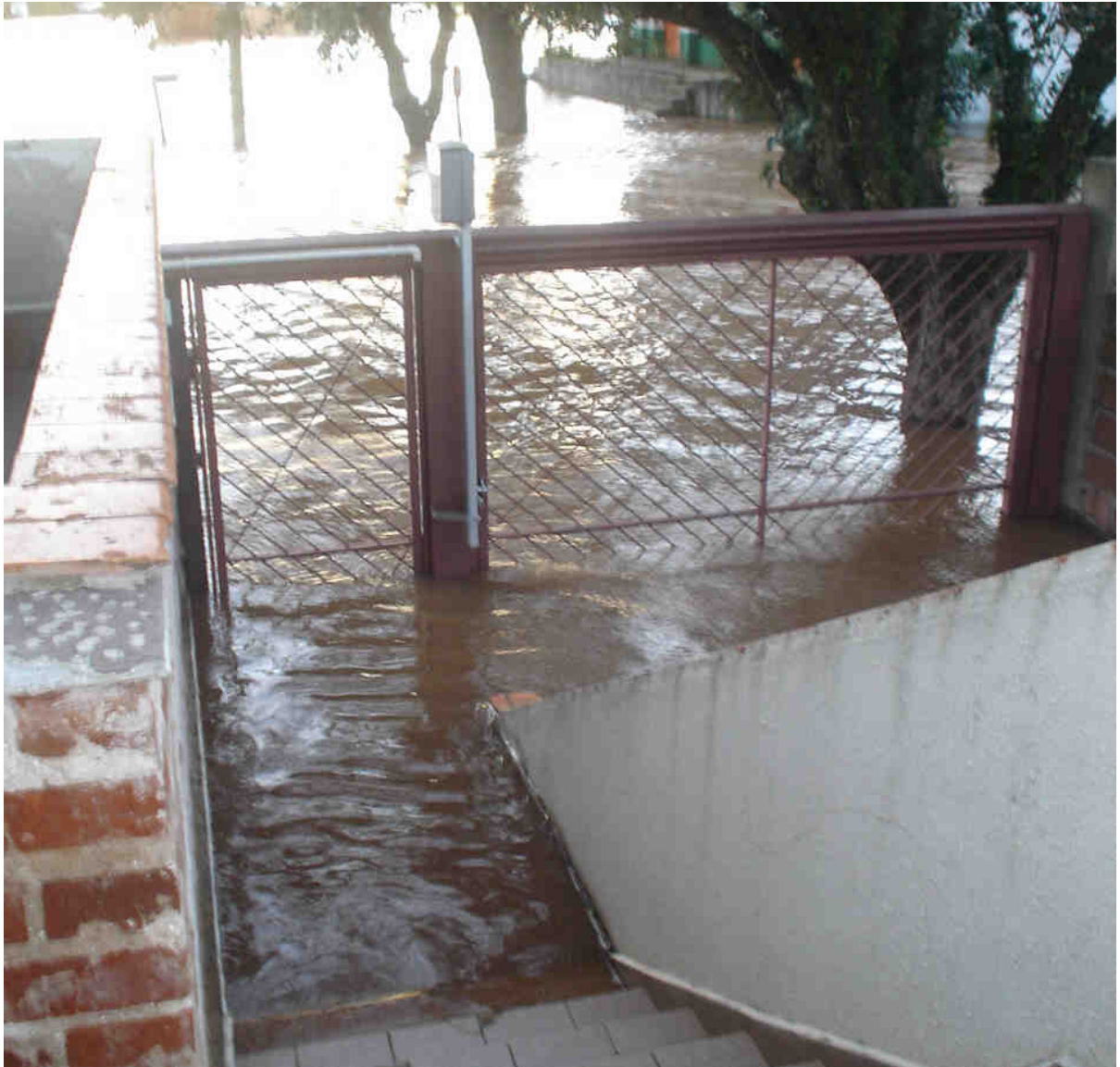
Figura 25 – Inundação de 2007: água invadindo uma residência.
