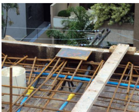
Figura 61: posicionamento dos inserts metálicos à armadura da estrutura
