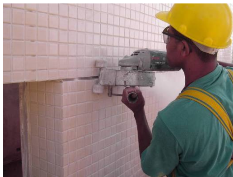
Figura 39: execução dos sulcos
