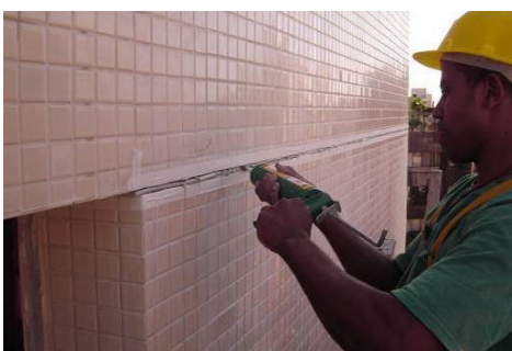
Figura 43: aplicação do selante
