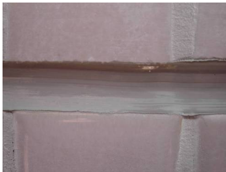
Figura 47: detalhe da junta de dilatação
