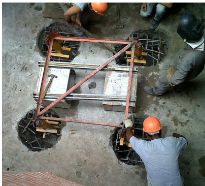
Figura 56: fundações da base da grua
