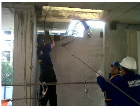
Figura 59: posicionamento do painel para fixação
