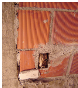
Figura 29: marcação da primeira fiada taliscada
