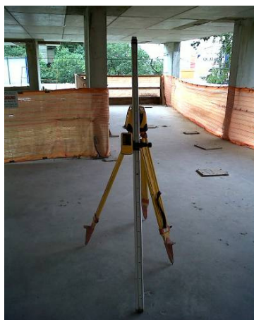
Figura 27: conferência de nível do pavimento
