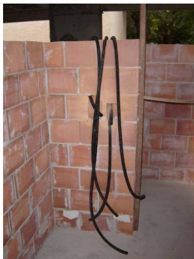
Figura 31: uso do escantilhão metálico e instalações embutidas executadas
