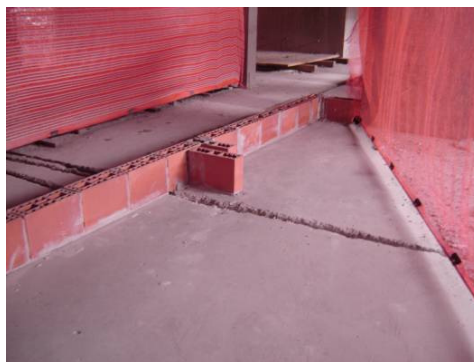
Figura 28: marcação da primeira fiada
