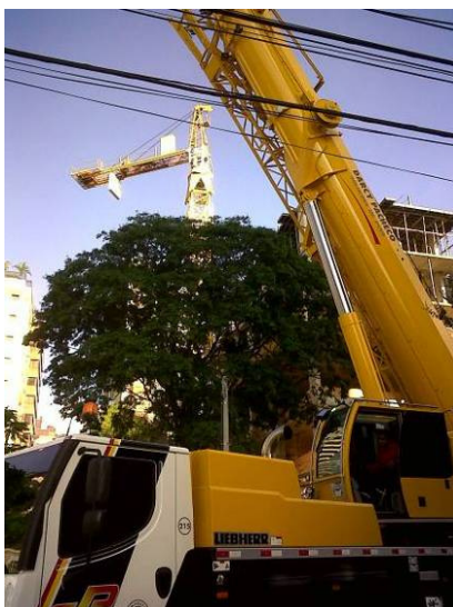
Figura 57: montagem da estrutura da grua
