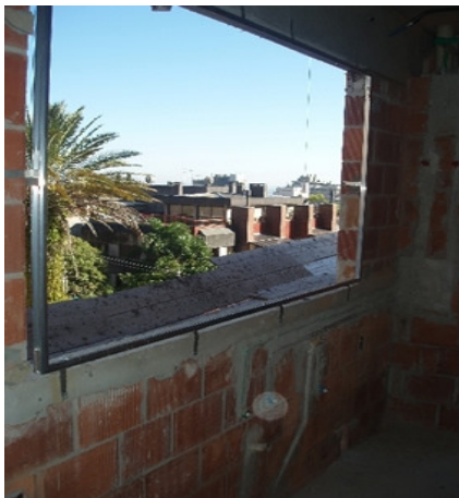
Figura 35: contramarco fixado com 1,3 cm de afastamento
