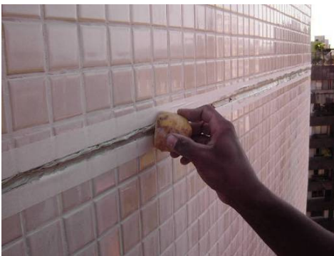
Figura 44: acabamento no selante com batata
