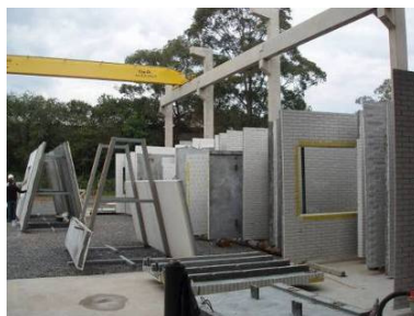
Figura 53: armazenamento dos painéis na fábrica
