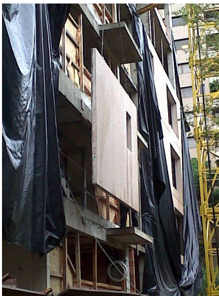
Figura 58: içamento do painel
