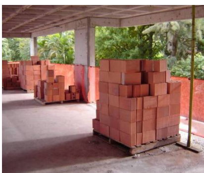
Figura 24: armazenagem de blocos no andar
