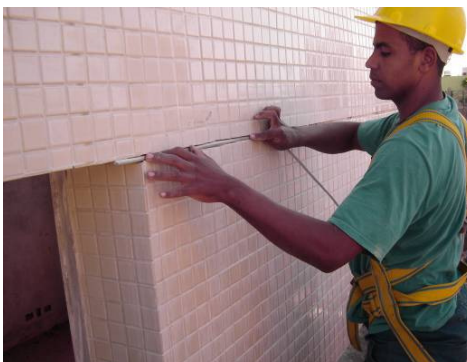
Figura 41: aplicação do limitador de profundidade – poliestireno
