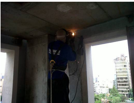
Figura 63: execução da solda
