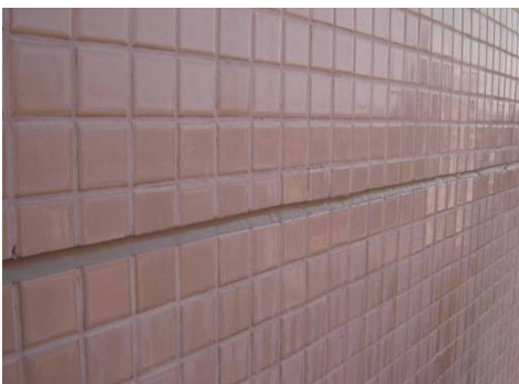
Figura 46: fachada limpa e isenta de resíduos
