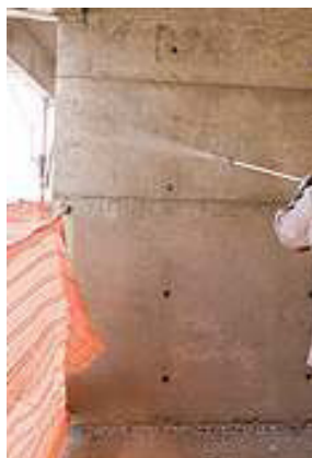
Figura 26: lavagem da estrutura com água fria
