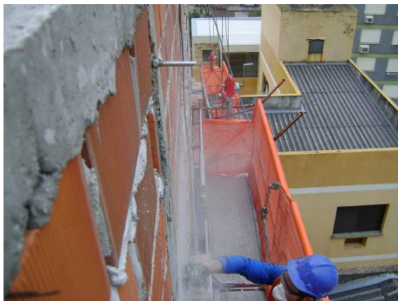
Figura 32: lixamento da estrutura de concreto
