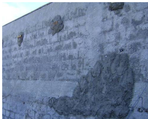
Figura 36: tela de fachada fixada
