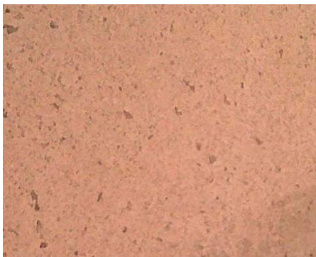
Figura 55: detalhe do acabamento do painel
