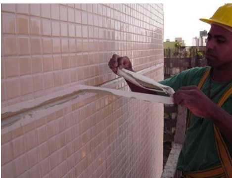
Figura 45: retirada da fita adesiva
