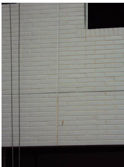
Figura 67: juntas executadas
