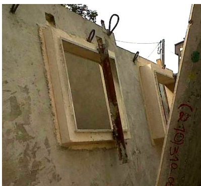
Figura 52: contramarcos instalados nos painéis
