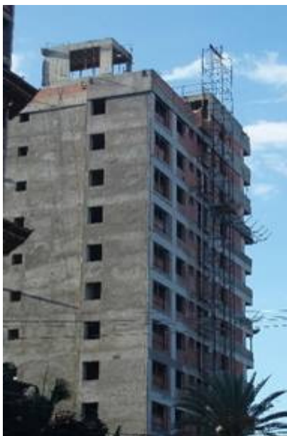
Figura 37: fachada rebocada
