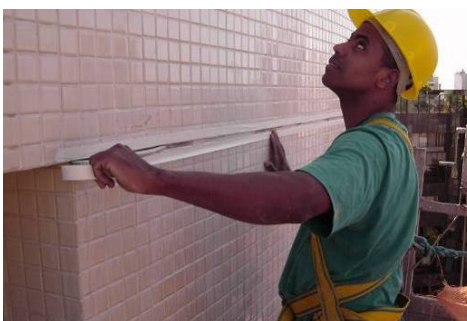
Figura 42: proteção das pastilhas com fita adesiva
