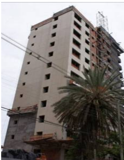
Figura 49: fachada sendo pastilhada
