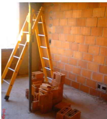
Figura 4: alvenaria de vedação de blocos cerâmicos
