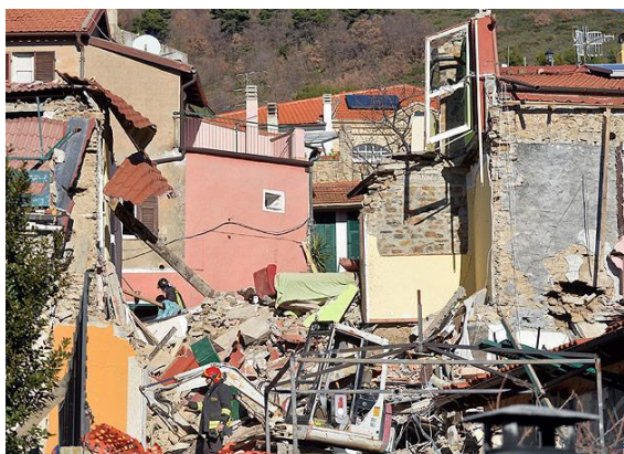
Figura 1.4 - Vazamento de gás causa explosão, prédio desaba, cinco vítimas
