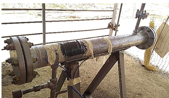
Figura 3.6.5 - Visão geral da tubulação após a cura inicial do reparo [Autor, 2022].
