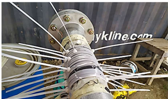
Figura 3.6.3 - Detalhe do apresilhamento do reparo para espera da cura do compósito [Autor, 2022].
