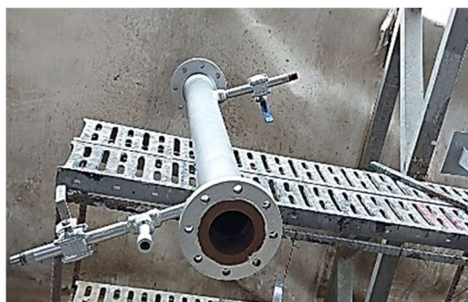
Figura 3.2.2 (g) - Conclusão da etapa de pintura [Autor, 2022].
