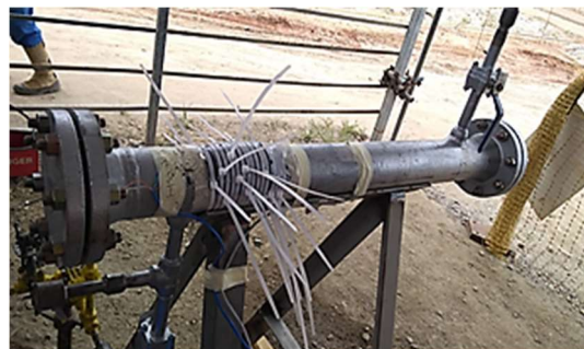
Figura 3.6.4 - Visão geral da tubulação, após o apresilhamento do reparo [Autor, 2022].
