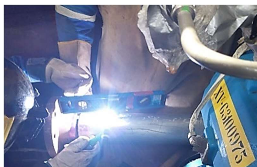
Figura 3.2.2 (b) - Execução do ponteamto para fixação dos flanges [Autor, 2022].
