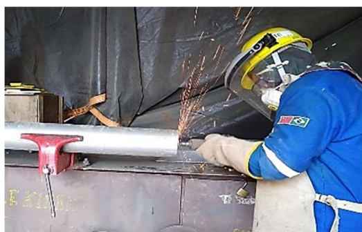
Figura 3.2.2 (a) - Preparação de bisel da tubulação para soldagem [Autor, 2022].
