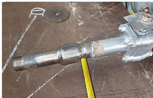
Figura 3.2.2 (e) - Acabamento da solda das conexões [Autor, 2022].
