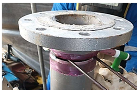
Figura 3.2.2 (c) - Flange ponteadado e alinhado, preparado para solda de enchimento [Autor, 2022].
