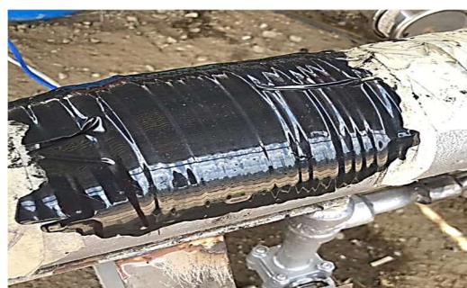
Figura 3.6.6 - Aspecto do reparo após a cura inicial [Autor, 2022].
