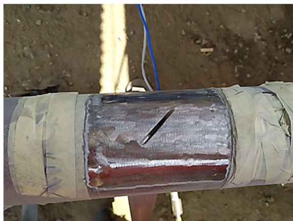
Figura 3.6.1 - Visão geral do reparo previsto antes da instalação [Autor, 2022].
