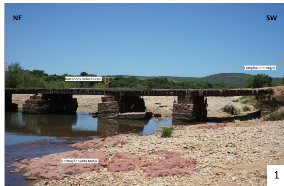
GM01 – Ponte sobre o Arroio Barracão cujo leito é constituído por lajeados da FSM. O arroio erode antigos terraços fluviais possivelmente pleistocênicos, formados com um nível de base mais elevado que o atual. Ao fundo, morros do CP.
