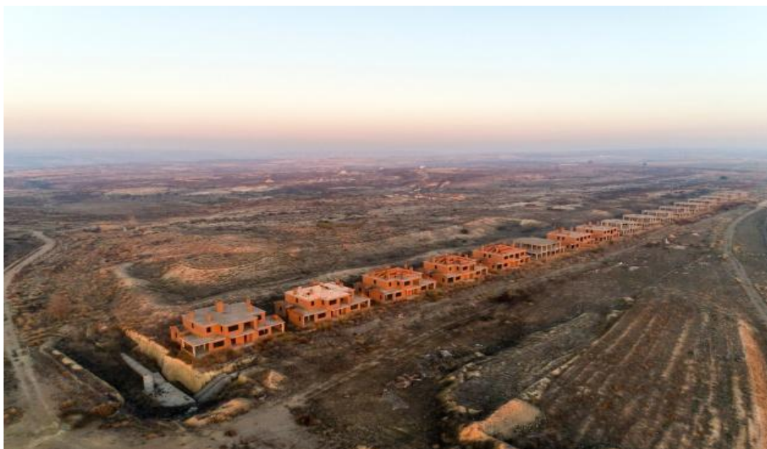
Figura 7 – Urbanização inacabada - San Mateo de Gállego, Zaragoza
