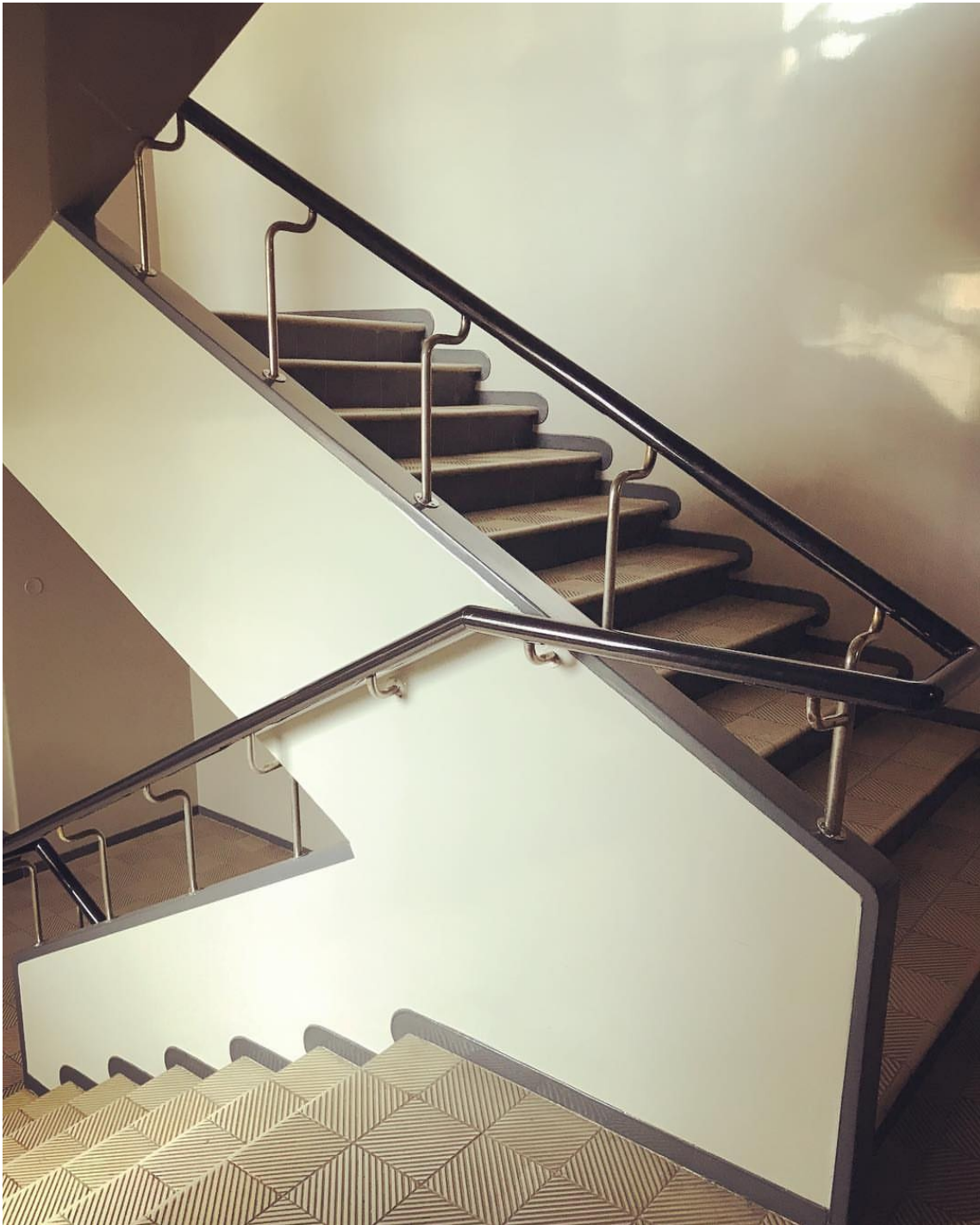
Turun Sanomat, Turku, Finlândia 1928, Alvar Aalto - Escadaria
